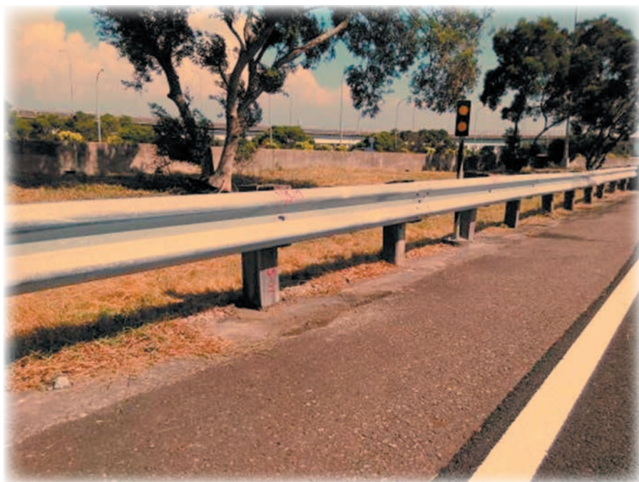
護欄柱修復（塑膠模）
