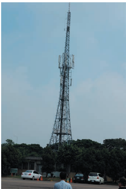
國道 1 號中壢機房通信鐵塔（角鋼式）
