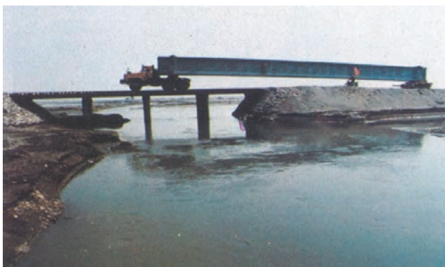
中沙大橋預鑄大梁使用便橋運輸至工地組裝
