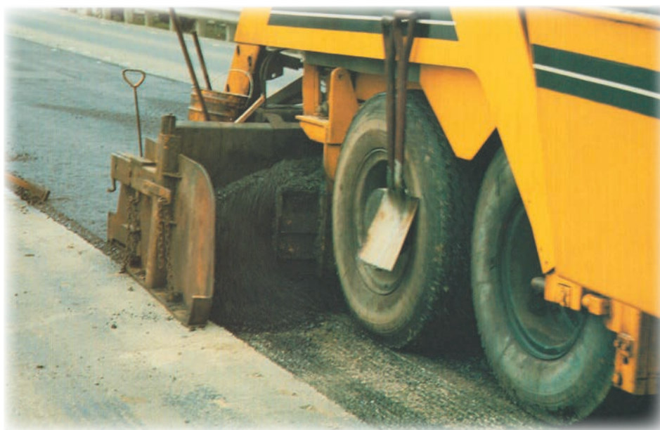
高速公路養護作業 - 既有 AC 路面刨除及重鋪
