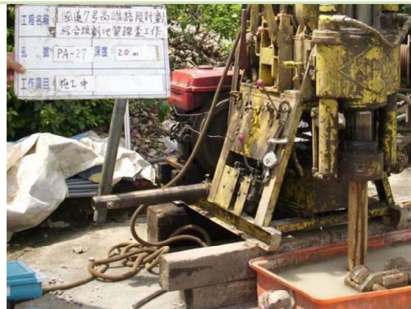
PA-27 號鑽探孔現場鑽探照片(施工中)
