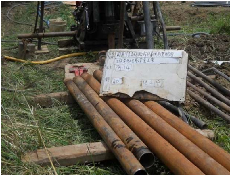
PA-14 號鑽探孔現場鑽探照片(施工中)
