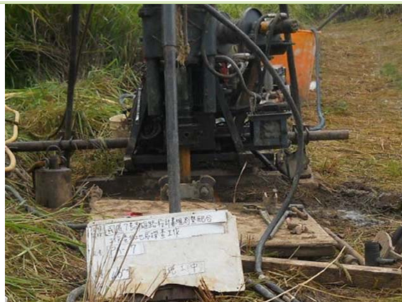
PA-17 號鑽探孔現場鑽探照片(施工中)
