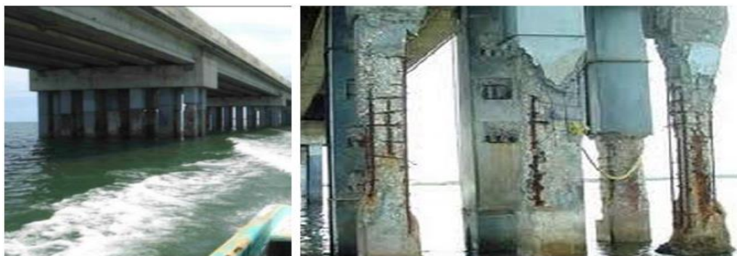
圖 3-50 La Unidad 舊橋腐蝕情形
