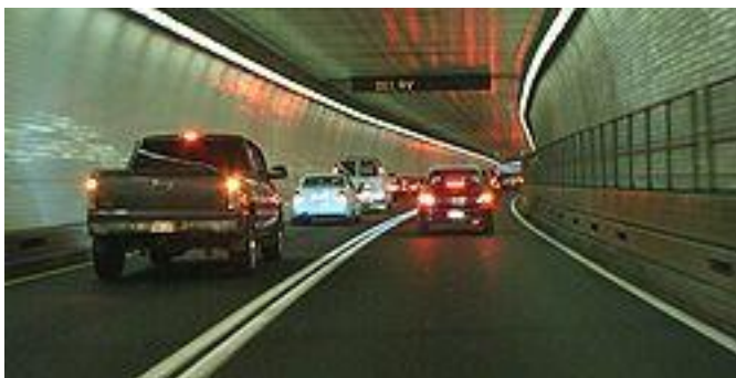
圖 10 隧道壁體採用磁磚
