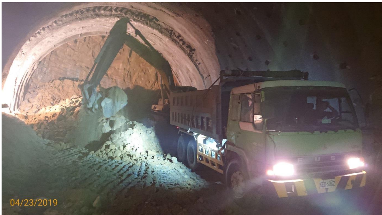
圖 2.豐原 2 號隧道東口西行線第 T265 輪進(20K+918.8~917.8)出碴
