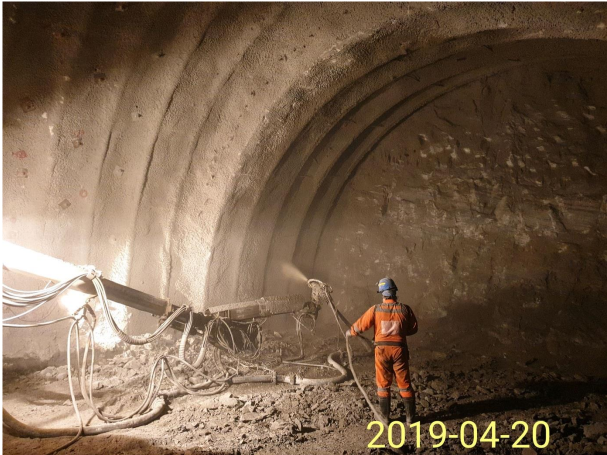
圖 1.豐原 2 號隧道東口西行線第 T260 輪進(20K+923.8~922.8)鋼纖維噴凝土施噴
