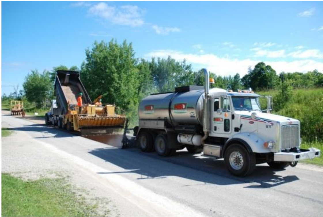
圖 3.4.2 灑布作業圖(圖資來源：PPRA 網站)
