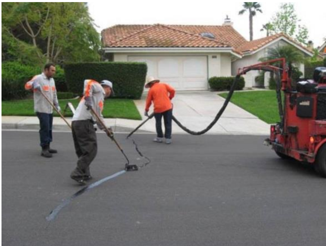
圖 3.1.2 填封施工圖(圖資來源：PPRA 網站)
