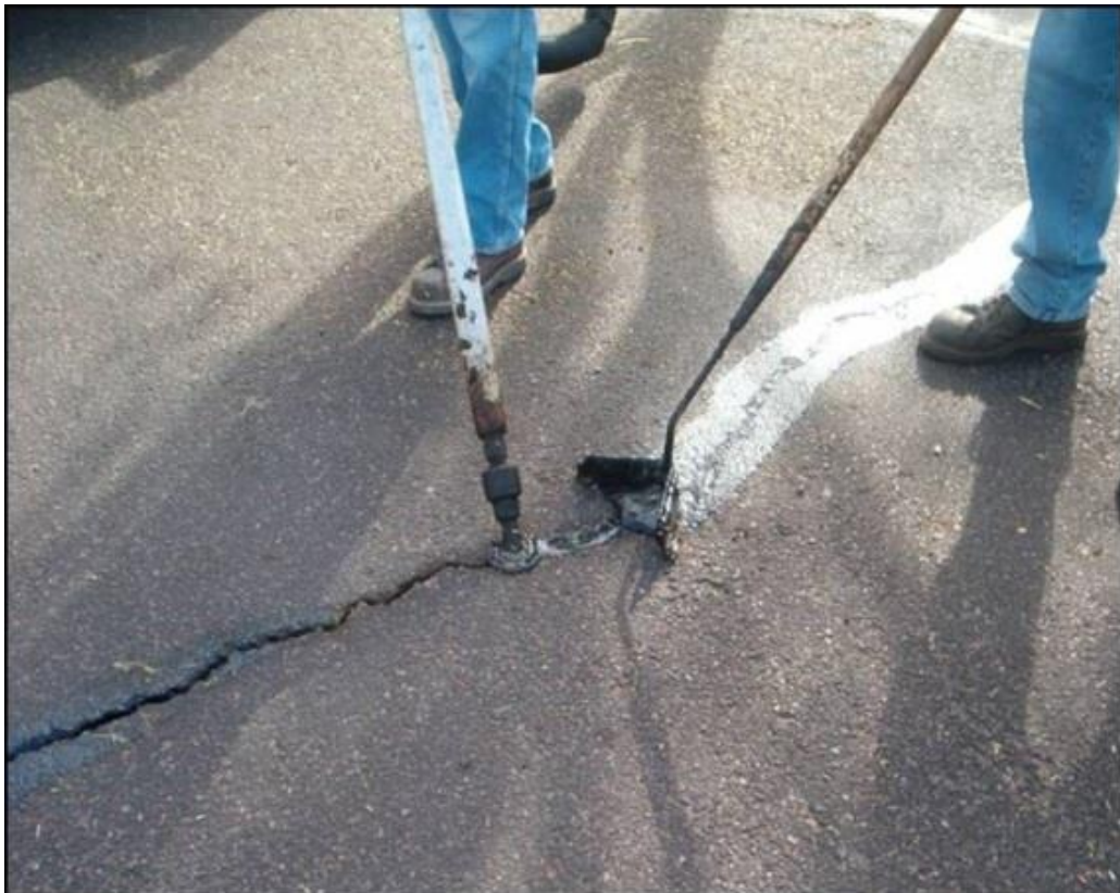
圖 3.1.1 填封作業圖(圖資來源：PPRA 網站)
