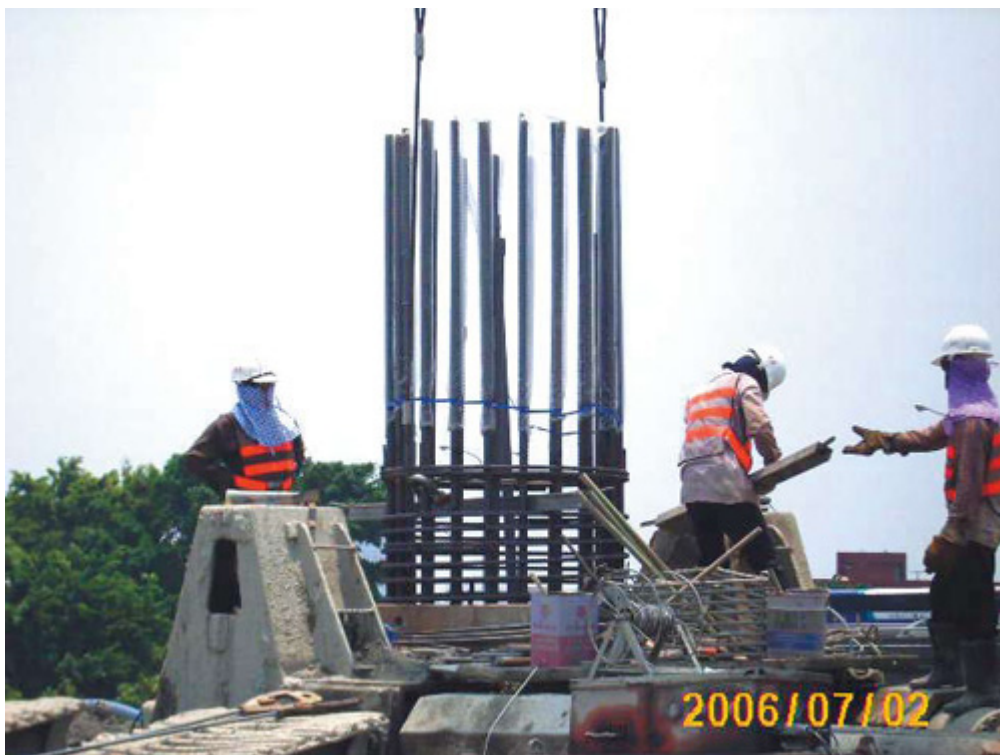
第204標工程墩柱基礎施工
