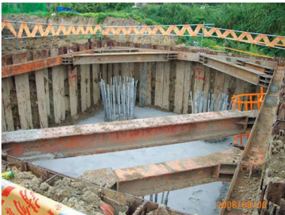
第204標工程基樁基礎施工
