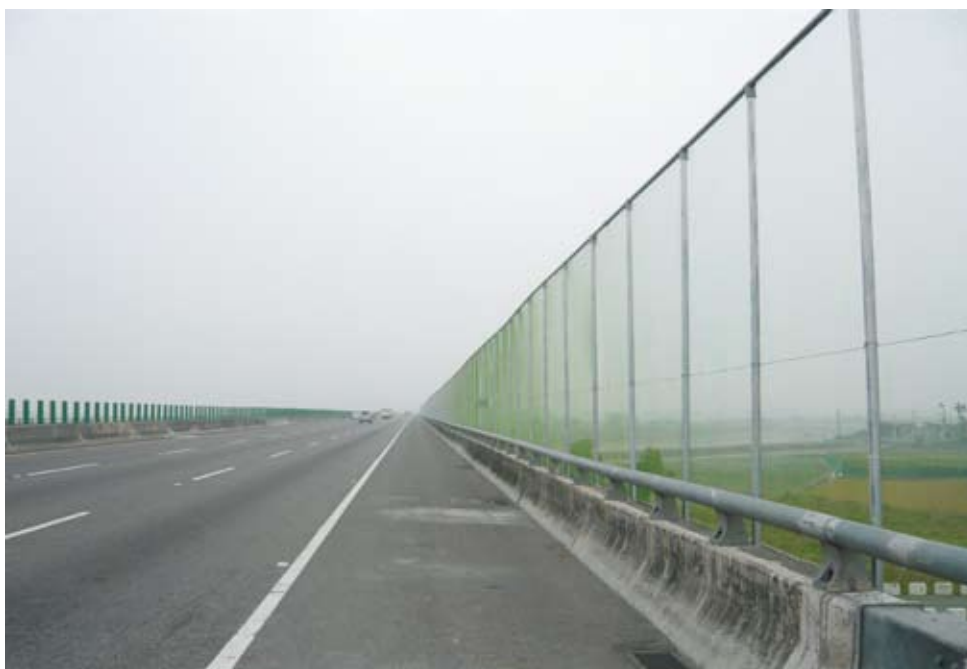
護欄設置防護網以提高紫斑蝶穿越國道時的飛行高度
