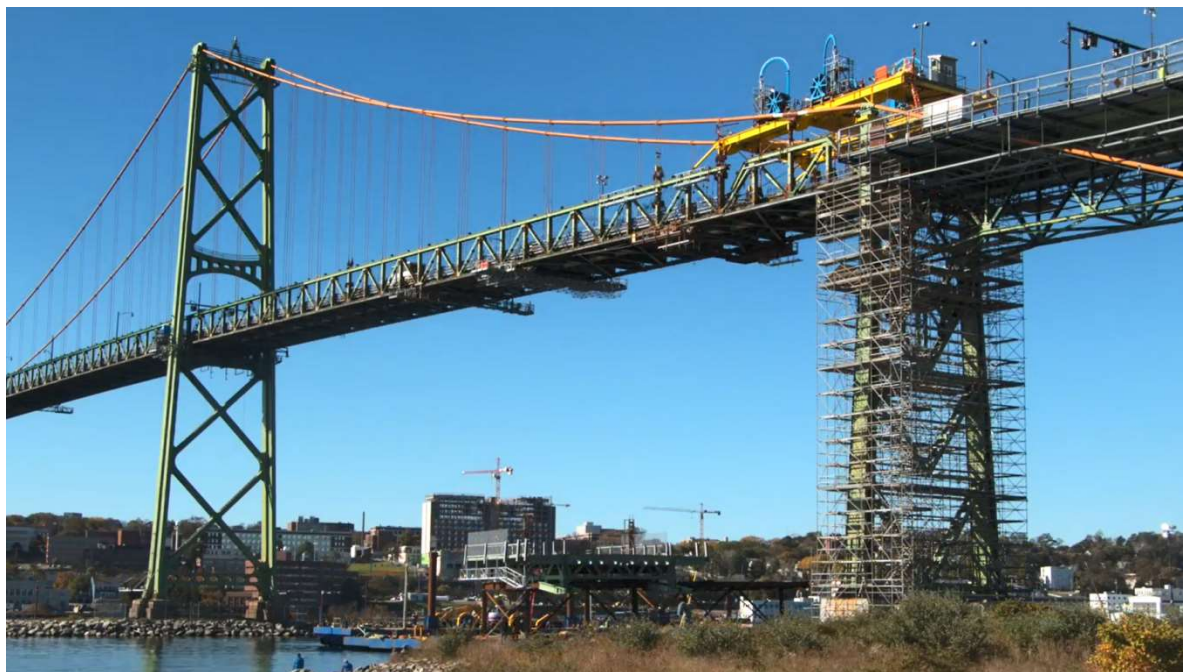
圖 19 大提升計畫吊梁工作車照片(摘自 HHB 簡報)
