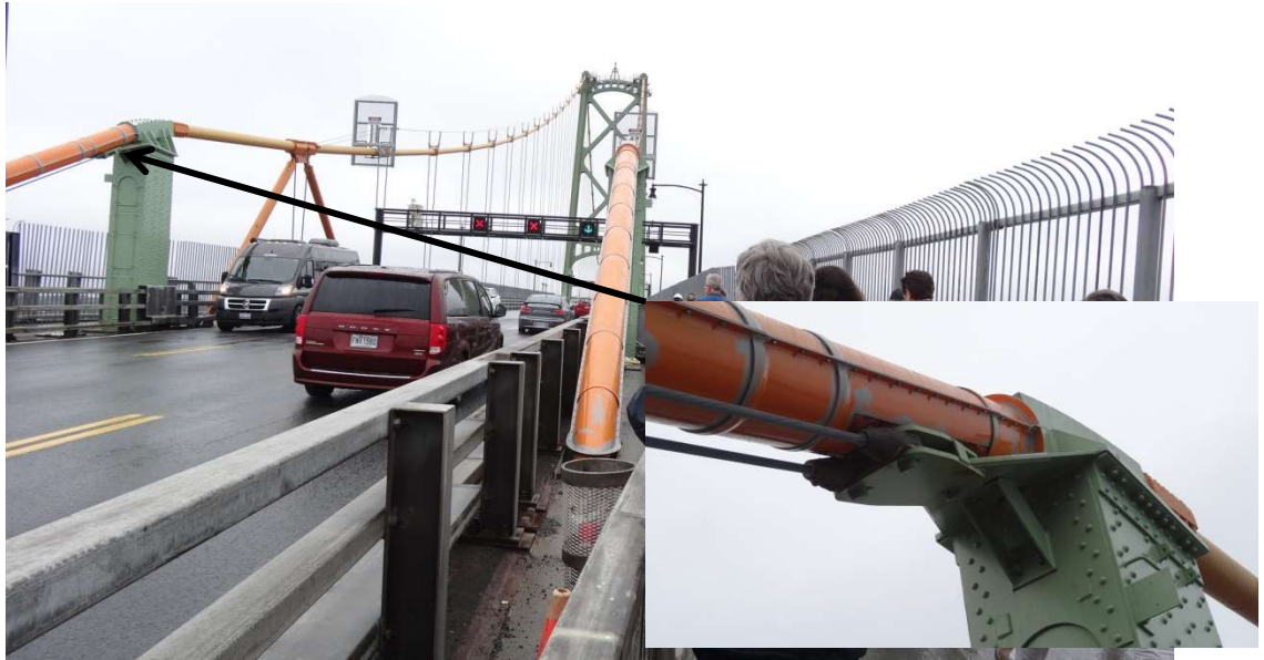
圖 10 Macdonald Bridge 主鋼纜錨碇座與邊跨墩柱增設之拉固鋼索
