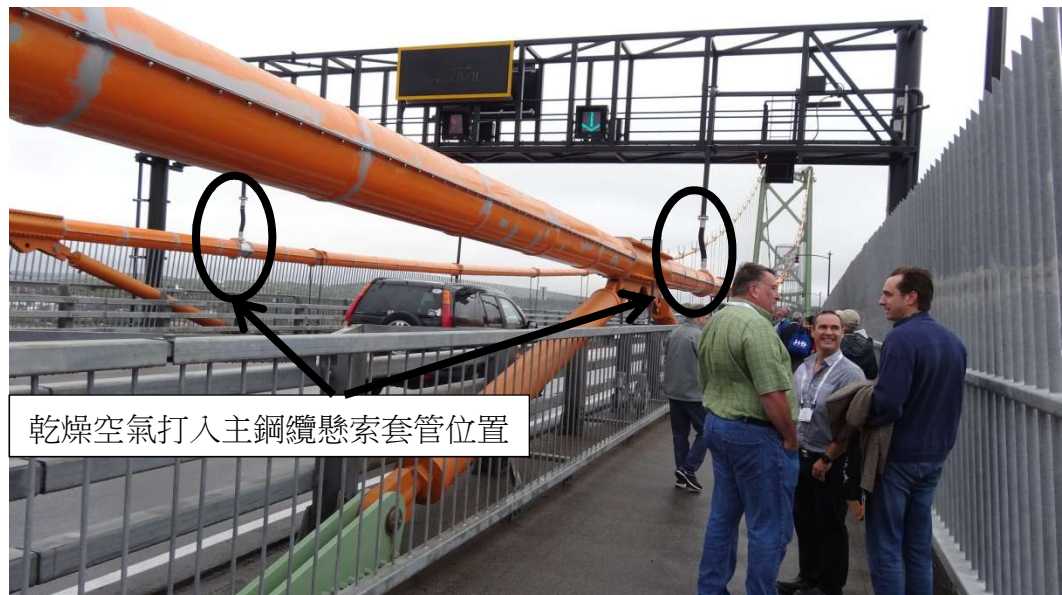
圖 8 Macdonald Bridge 主鋼纜乾燥空氣打入主鋼纜懸索套管位置照片
