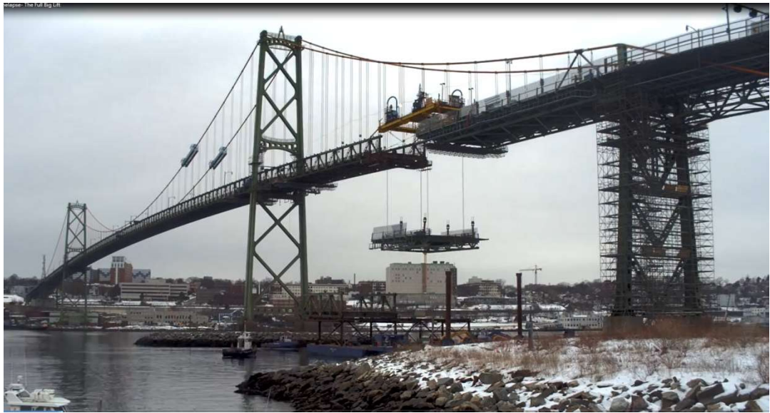
圖 22 預鑄完成之新橋面自橋下駁船吊升銜接照片(摘自 HHB 簡報)
