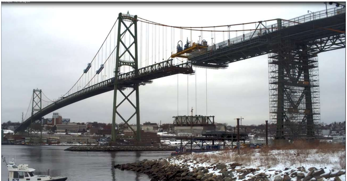
圖 21 舊橋面板切除後吊放至橋下駁船照片(摘自 HHB 簡報)
