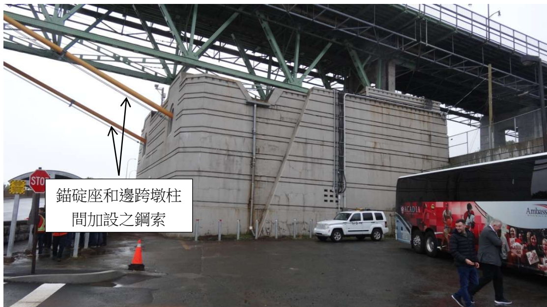
圖 9 Macdonald Bridge 南岸主鋼纜錨碇座機房照片
