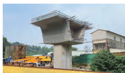
第 C712 標 中坑溪橋 PE1 柱頭節塊完成
