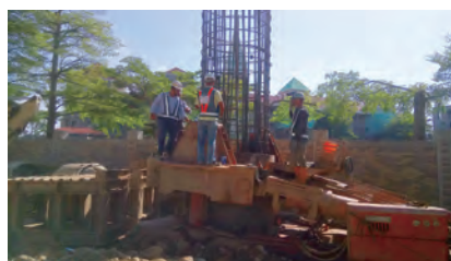
第 C715 標 P33R-1 基樁鋼筋查驗
