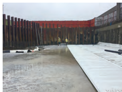
第 E252 標 地下一層基礎防水膜鋪設
