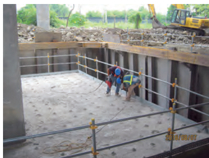
第 M41 標 P42R 基礎植筋鑽孔
