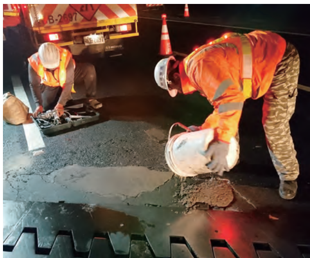
交通管制之施工區內，所有人員應依規定穿著反光衣 (背心) 及戴安全帽
