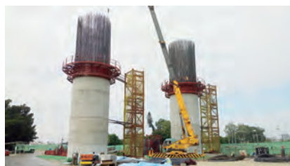
第 C714 標 P8E/W 墩柱昇層繫筋
