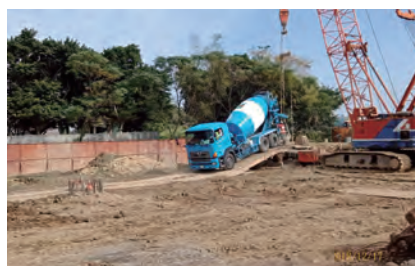
第 H72 標 EBP5L#2 全套管基樁 混凝土澆置
