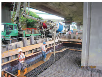
第 M41 標 P44R 基礎 SCC 混凝土澆置
