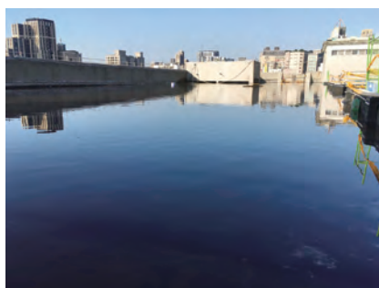
博一工程 屋頂防水層試水作業
