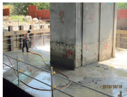
第 M41 標 P46R 基礎表面水刀處理施工
