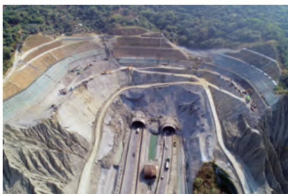
第 D11 標 中寮隧道路塹施工空拍圖
