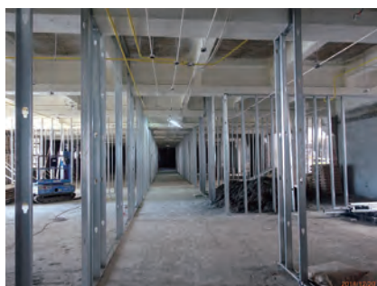
博一工程 輕隔間骨架組立
