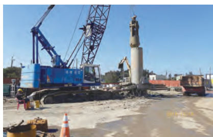
第 H72 標 T15RP4#1 全套管基 樁鑽掘施工
