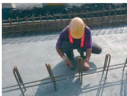
第 E252 標 洗車台鋼筋組立施工
