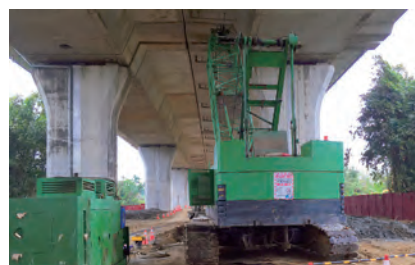
第 M37D 標 南投高架橋全套管基 樁施工
