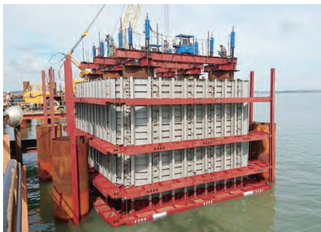
第 CJ02-2C 標 第 1 座樁帽圍堰 (小金引橋段 P15) 下放
