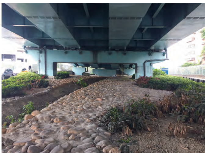
國道 3 號土城交流道高架橋下設置雨水澆灌系統
