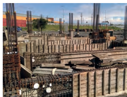
第 E252 標 東側廁所地梁鋼筋模板組立
