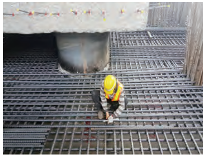
第 M37C1 標 基礎鋼筋綁紮
