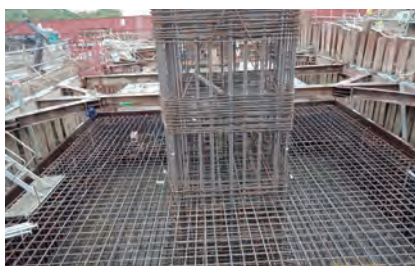
第 H72 標 EBP11R 基礎鋼筋綁紮
