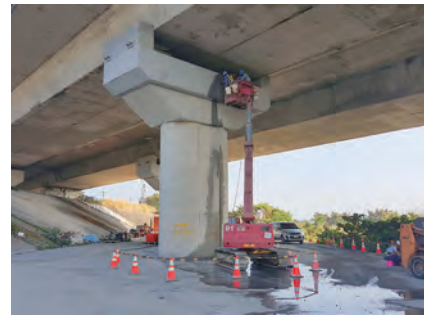
第 M37C1 標 液態阻尼器安裝前鑽孔
