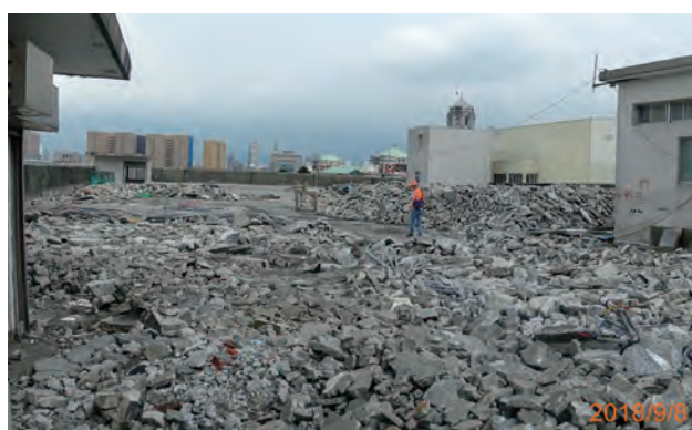
博一工程 屋頂既有防水隔熱層拆除
