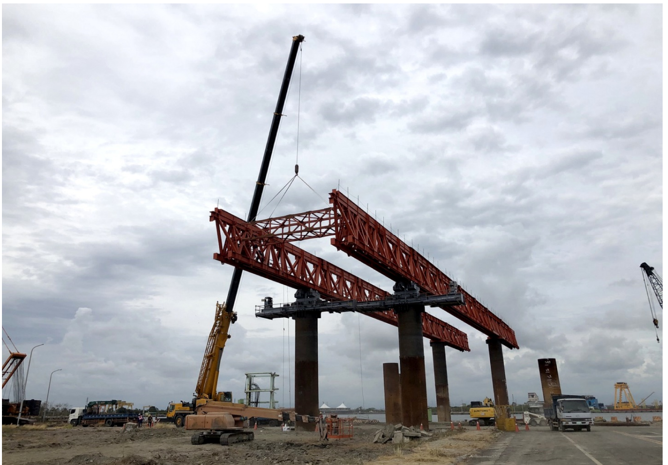
圖 6 興達港吊運桁架橫梁
