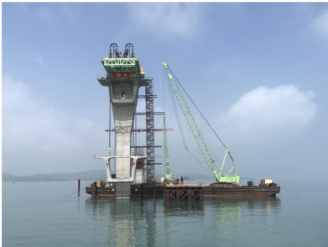
金門大橋上構箱梁，第一組預鑄節塊開始吊裝
