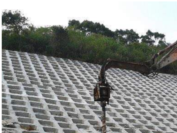
圖 3.3.3-6 型框護坡工法
