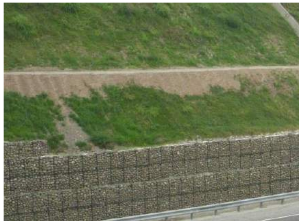
圖 3.3.3-1 箱籠擋土牆工法
