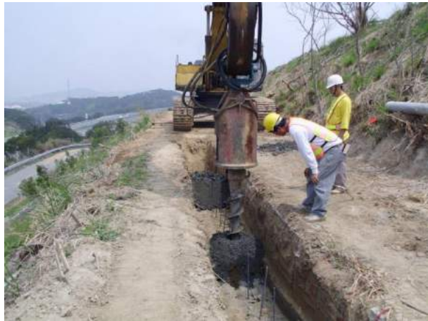
圖 3.3.3-5 微型樁工法
