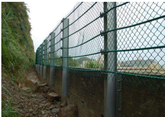
圖 3.3.3-12 攔石柵（網）工法
