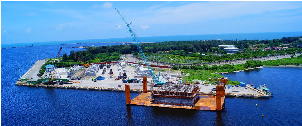
圖 1-11 沉箱、方塊及消波塊於安平港施作
