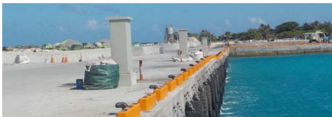
圖 1-22 碼頭岸電設備完成圖
