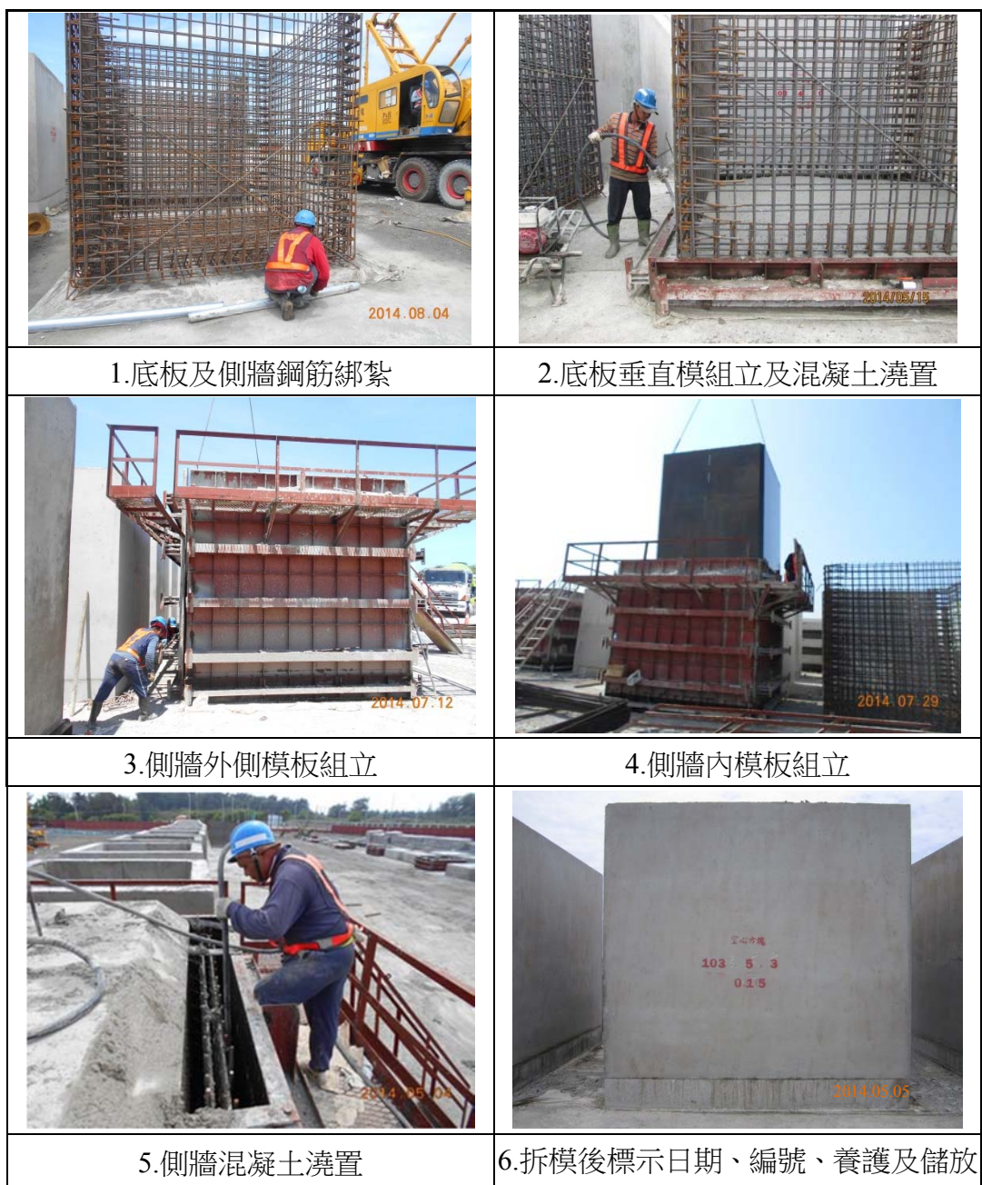
圖 1-48 空心方塊施工相片
