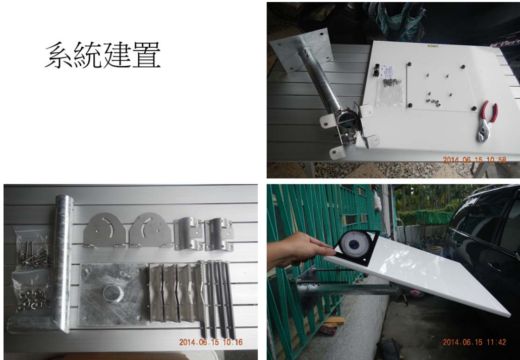
圖 1-39 衛星網路天線架設
