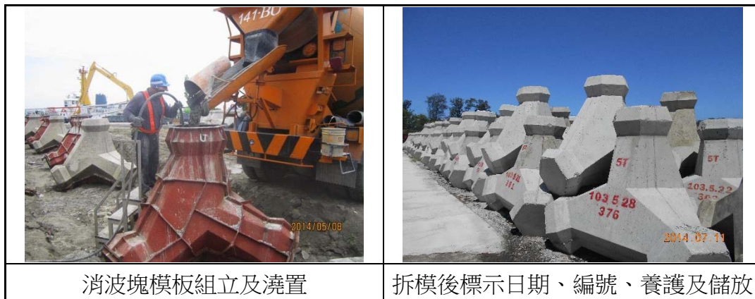
圖 1-45 5T 消波塊施工相片
