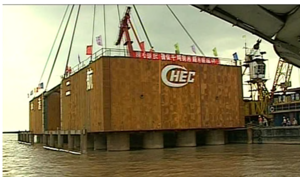
鋼箱圍堰-吊放樁帽預製鋼模
