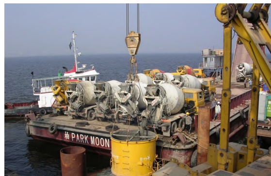
平台船載運混凝土拌合車
