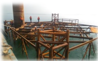
外套鋼管打設
