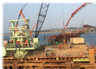
基樁混凝土澆置
