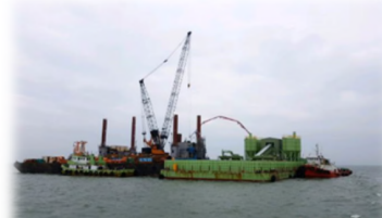
海上拌和船混凝土澆置
