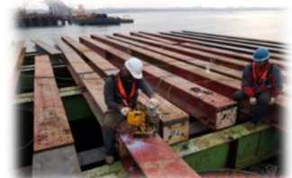
施工構台設置
