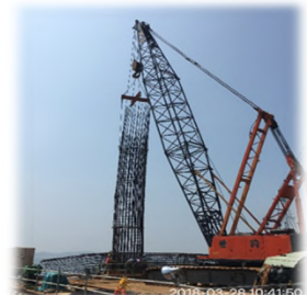
鋼筋籠吊放搭接
