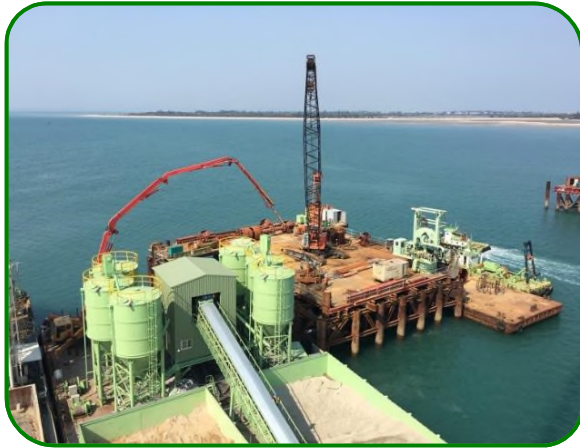
P48基樁採用構台施作
