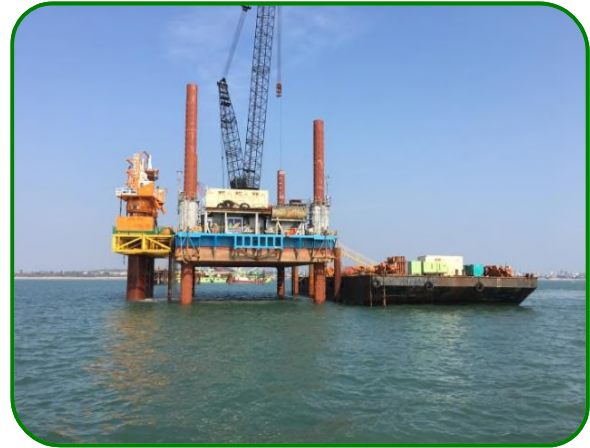
P46基樁採用頂昇式平台船施作
