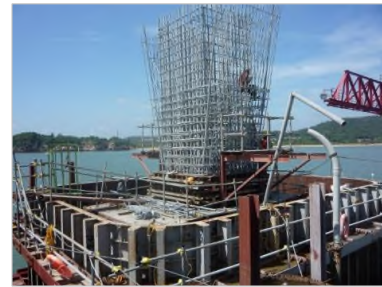
鋼箱圍堰及下構施工情形
