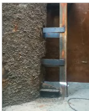
套管截斷前施工情形
