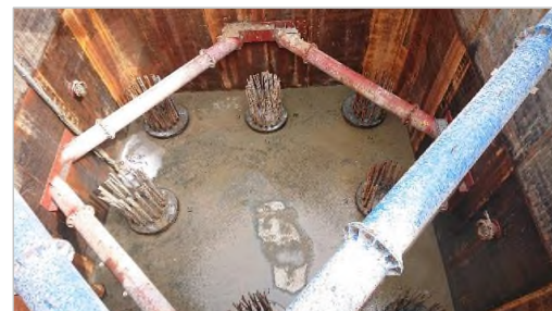
鋼箱圍堰工作面樁頭處理完成
