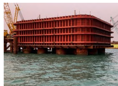
本工程單壁式鋼箱圍堰
