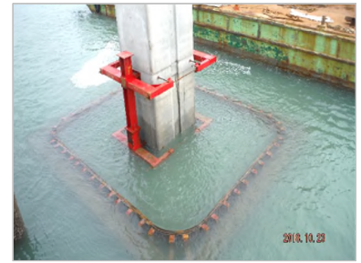
鋼箱下層側壁拆除
