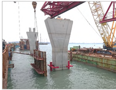
鋼箱上層側壁拆除
