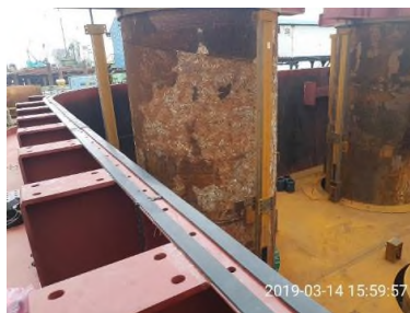
壁體接合部止水施工
