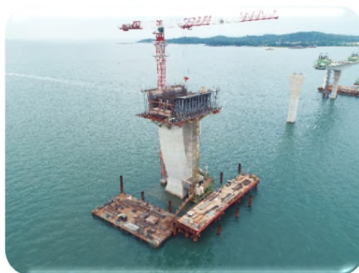
各墩配置施工構台或平台船
