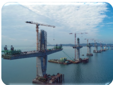
主橋配置塔式吊車
