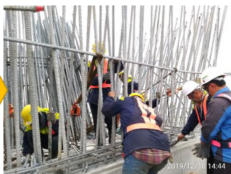
鋼筋保護層調整
