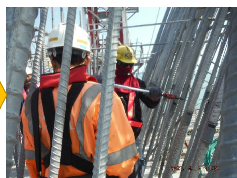
鋼筋續接後扭力試驗(15%)
