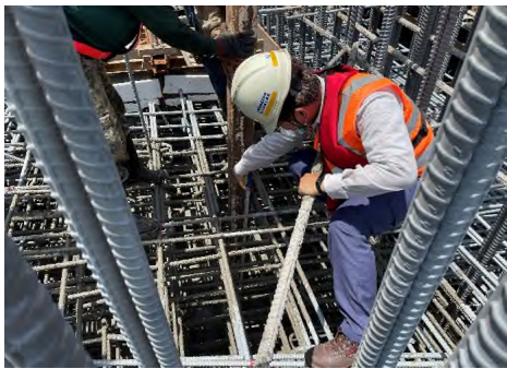
灌漿管澆置高度確認(墩柱)
