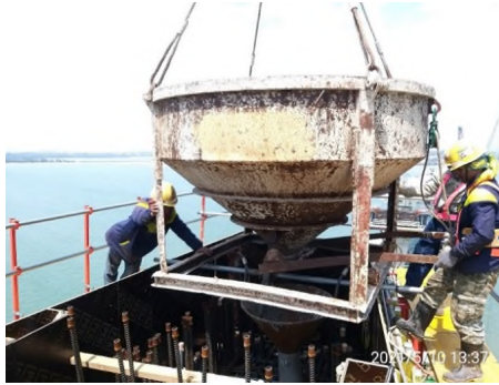
吊桶+卸料管澆置(橋塔)
