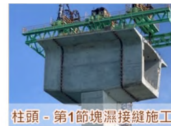
柱頭－第1節塊濕接縫施工
