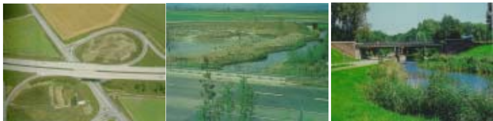
圖 2.3.16 在高速公路交流道旁設置的自然雨水滯留池(台灣大學農學院農村規劃與發展中心編譯, 1998, p.79)(左)。德國某交流道的生態水池建設。(林憲德, 1999, p.223)(中)。荷蘭聯絡公路兩旁野生公園的橋樑下動物路徑。在橋樑下的綠帶上放置成排的枯木樹枝，以掩護小動物的移動(右)。(林憲德, 1999, p.142)
