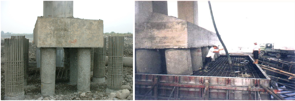
圖 7-7 增樁施工與擴基施工
