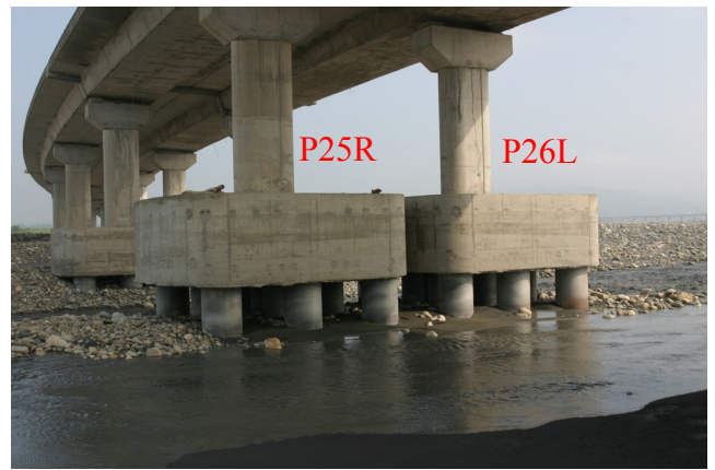
圖 3-3 橋墩 P25R/P26L 裸露情形(2009/10/13)
