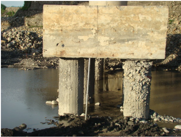
圖 4-12 鏤空外套管埋設
