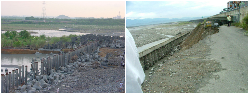
圖 7-6 排樁工法之應用情形
