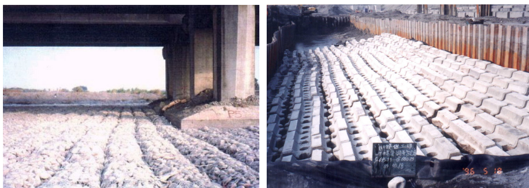
圖 7-4 蛇籠護坦與混凝土塊護坦工法之應用情形
