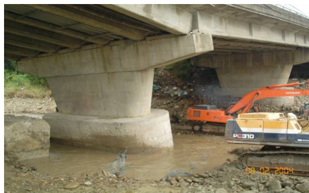
圖 2- 14 龜山大橋損壞情形
