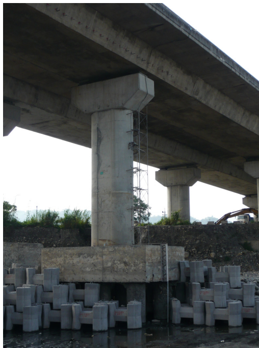
圖 4-14 非埋入式沖刷監測儀器架設完成
