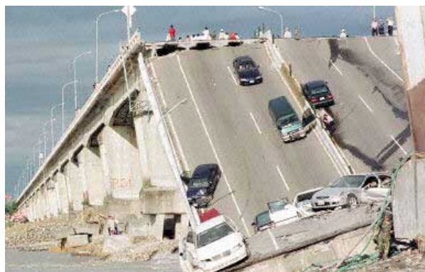
圖 2- 13 高屏大橋損壞情形
