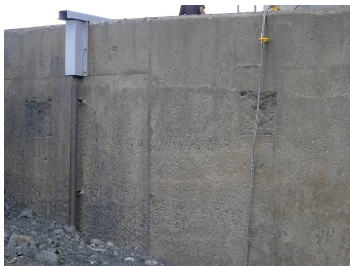
圖 4-21 埋入式數位感測沖刷監測儀器架設完成
