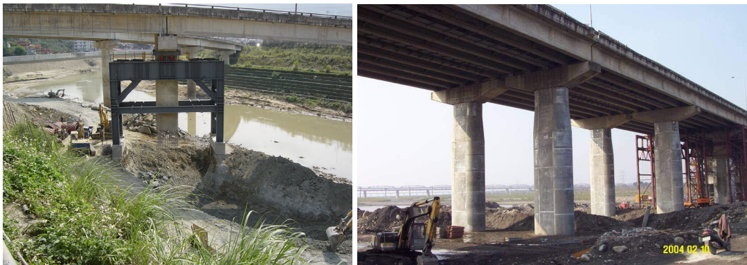
圖 7-8 拆除原有基礎與連接完工之情形
