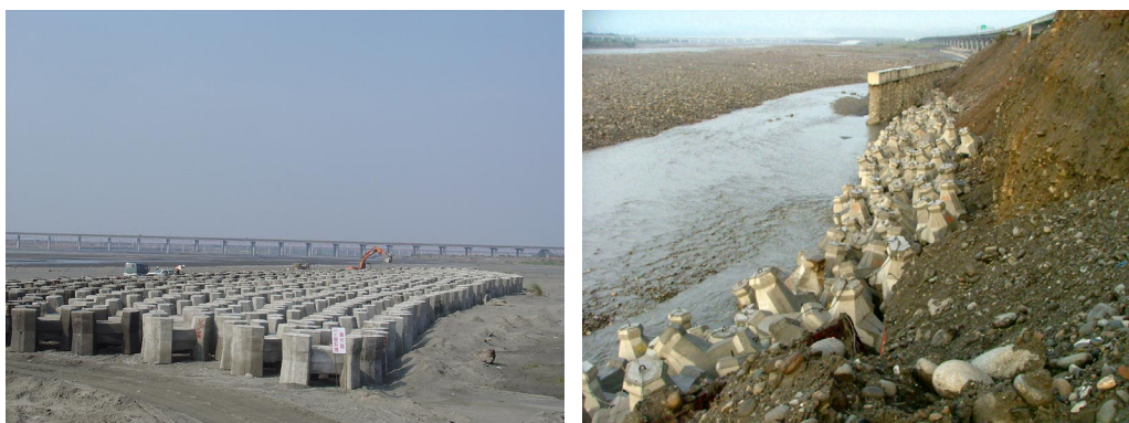
圖 7-3 混凝土塊排置工法應用之情形
