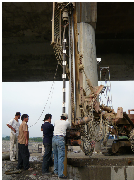
圖 4- 19 埋入式數位感測沖刷監測儀器埋設
