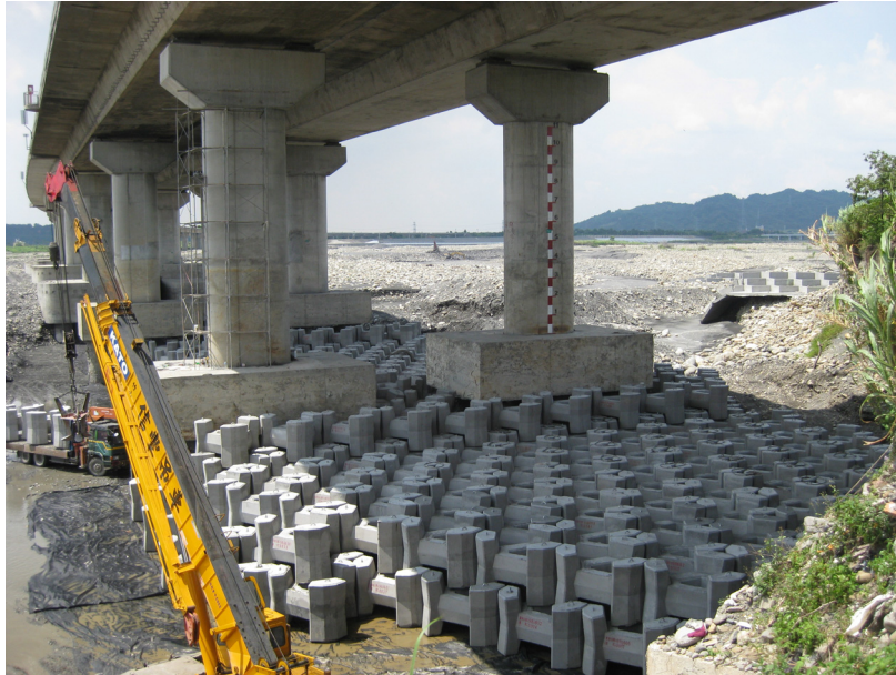
圖 3-11 98 年 7 月底完成濁水溪橋橋基保護工程照片
