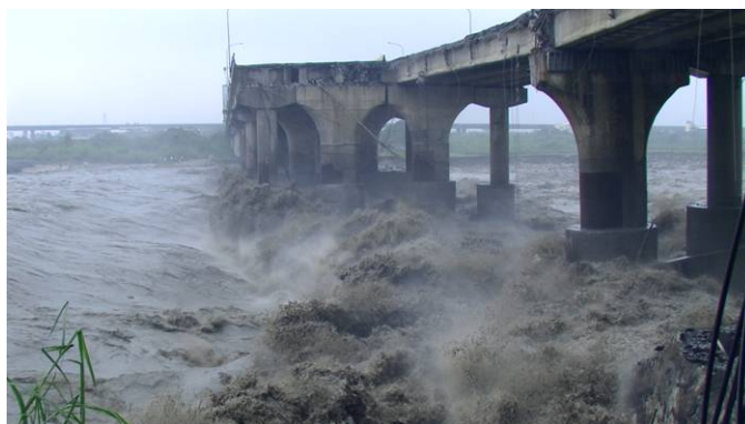
圖 2- 16 后豐大橋損壞情形
