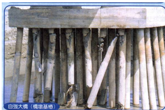
圖 2- 15 自強大橋損壞情形
