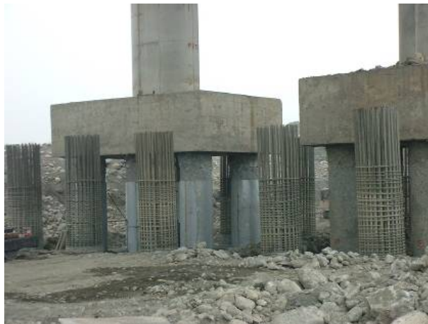
圖2- 11 托底工法施工之情形
