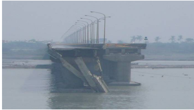
圖 2- 17 雙園大橋損壞情形
