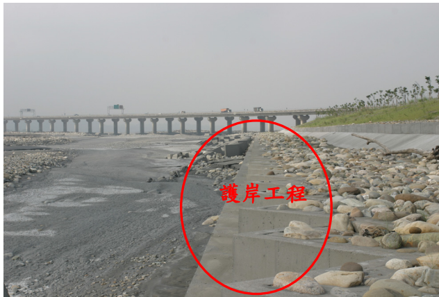
圖 3- 5 橋址北岸上游護岸工程(2009/10/13)
