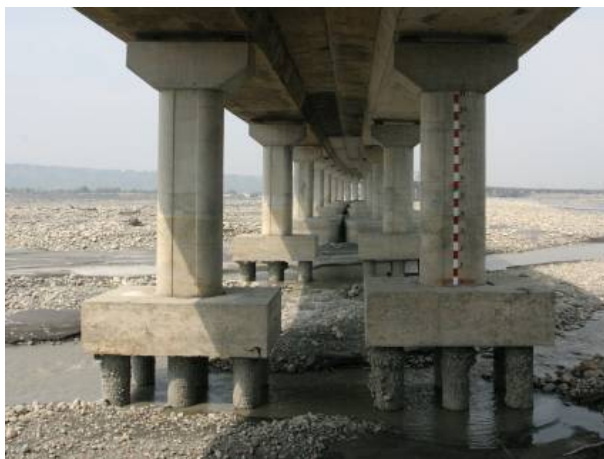
圖2- 12 98年2月基樁裸露之情形
