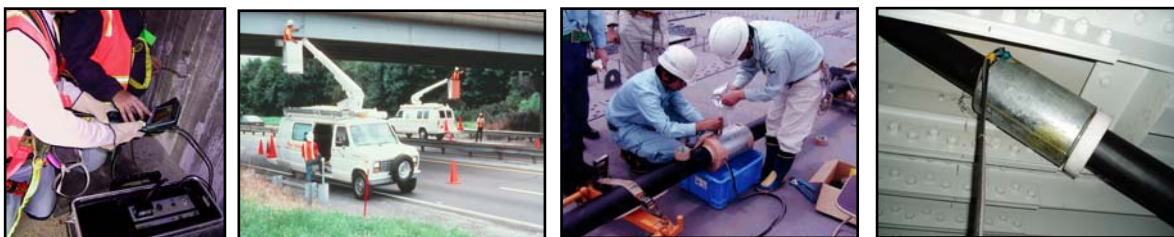
圖 6.4-7 橋梁檢測養護及鋼索之張力感測計(Elasto-magnetic Sensors, EM Sensors)
