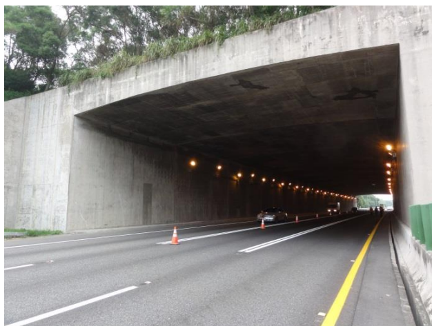
圖 3.3.3-13 明隧道工法
