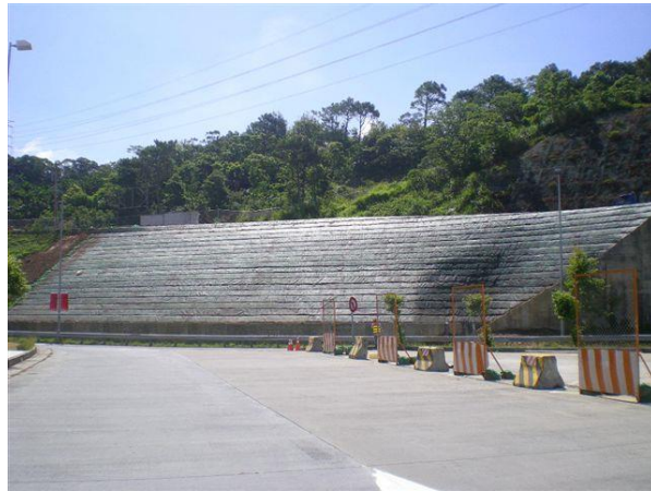
圖 3.3.3-2 加勁擋土牆工法
