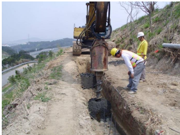
圖 3.3.3-5 微型樁工法
