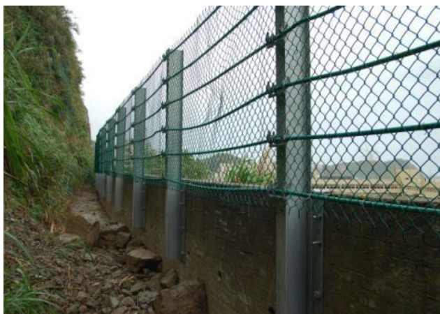
圖 3.3.3-12 攔石柵（網）工法
