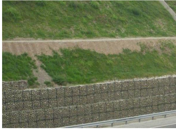
圖 3.3.3-1 箱籠擋土牆工法
