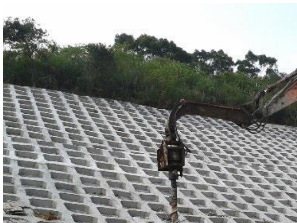
圖 3.3.3-6 型框護坡工法
