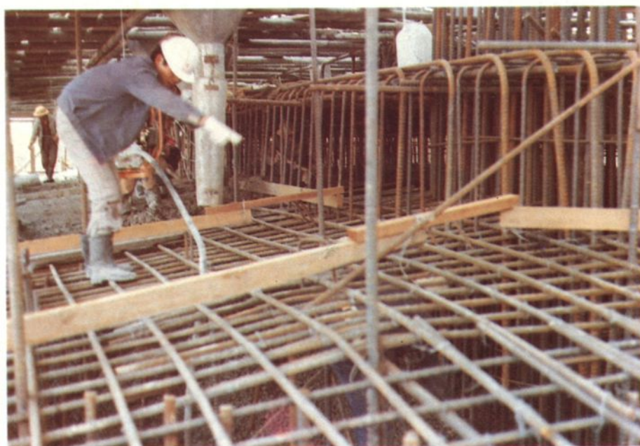
▲基脚鋼筋及澆注混凝土
