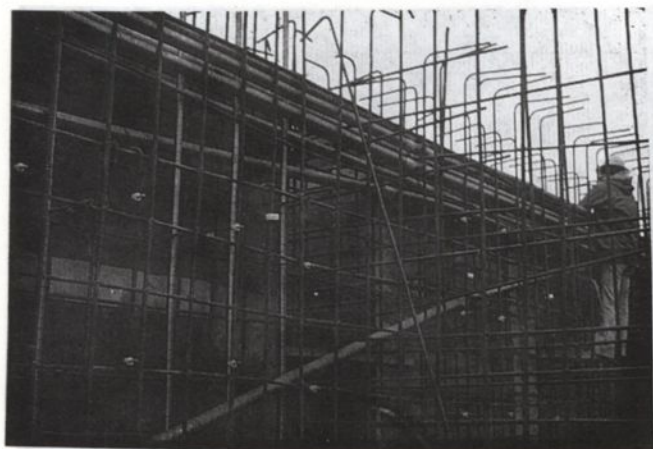
照片 5 - 3 梁腹排套管
