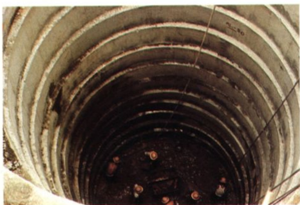
▲掘井式沉箱 (P D )
