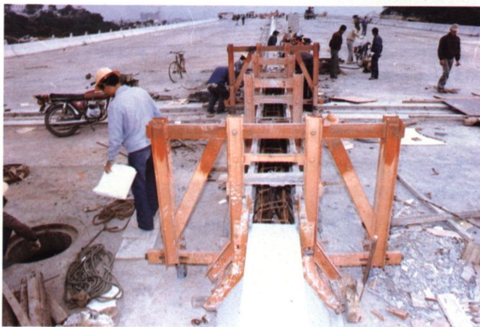
▲中間分隔牆施工情形
