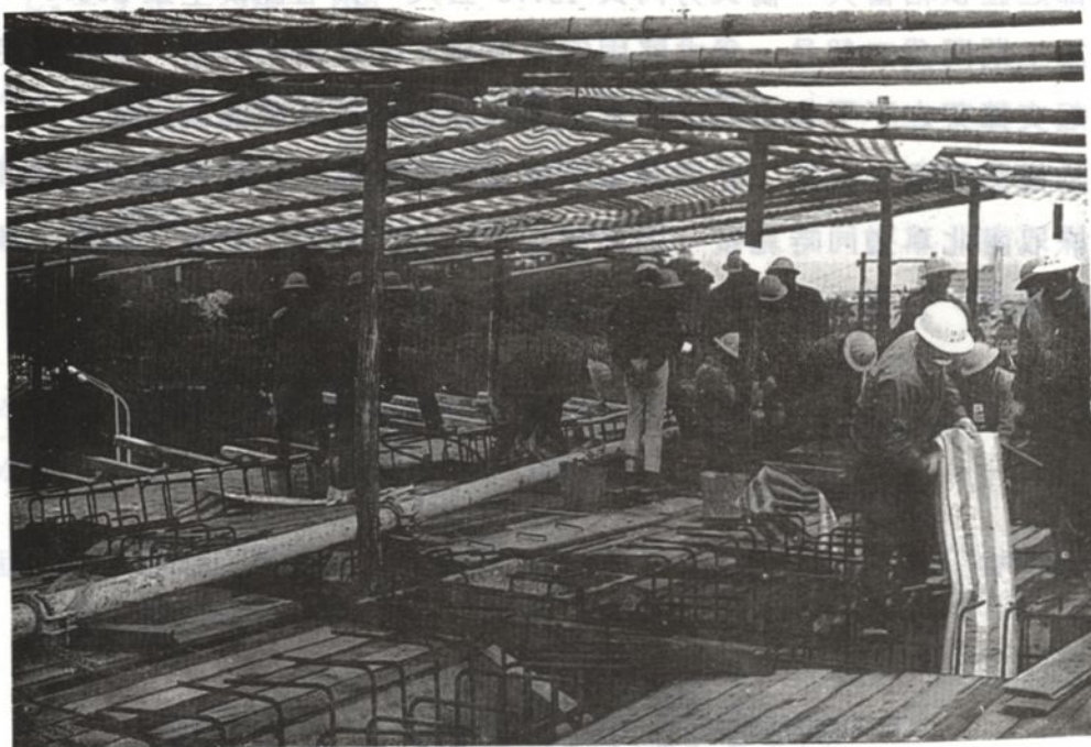
照片 5 - 1 梁腹澆注混凝土
