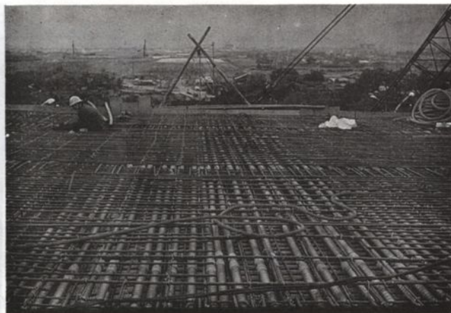
照片 5 - 4 柱頭部頂橋間鋼筋及鋼腱
