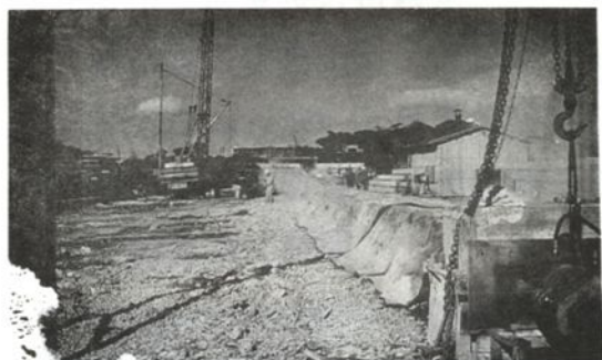
照片 3-6 蒸氣養護
