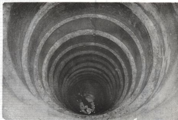
照片 3 - 10 沉箱開挖情形
