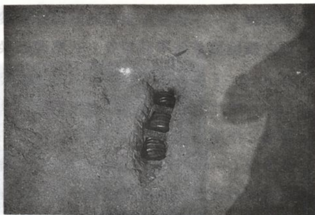
橋面打洞 照片 5 - 6
