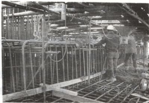
照片 4-1 基礎混凝土
