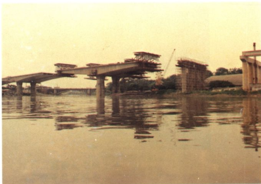
►河中懸臂梁施工情形(P A )
