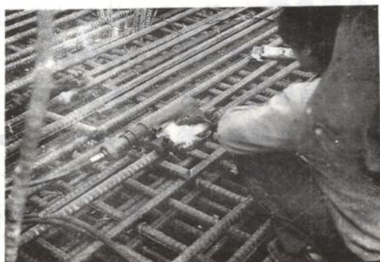
照片 4-2 鋼筋壓接
