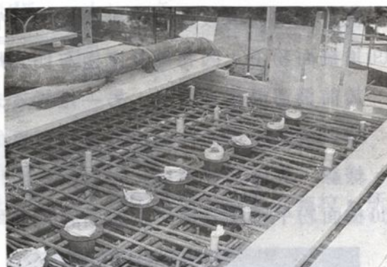
照片 7-4 鋼筋套管預留孔之位置(1) 照片 7-5 鋼筋、套管、預留孔配置(2)
