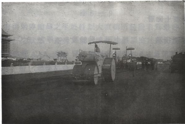
照片 8 - 4 瀝青混凝土面層之施工
