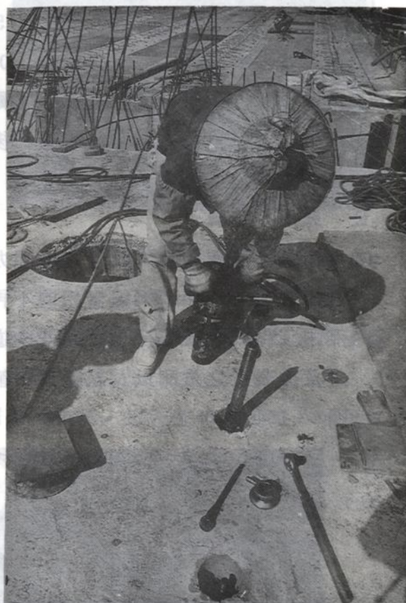
照片 7 - 12 垂直鋼棒施預力
