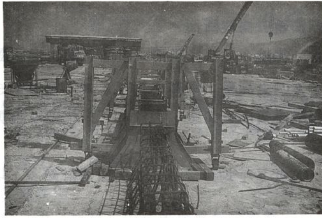
照片 8 - 3 中央分隔欄之施工
