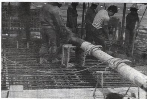
照片 7-6 頂板混凝土
