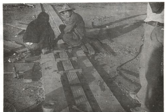
照片 8 - 1 伸縮縫之安裝
