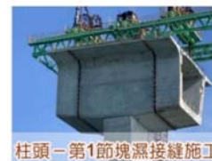
柱頭－第1節塊濕接縫施工
