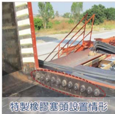
預力套管及端錨設置情形
