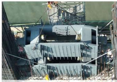
橋塔鋼殼安裝 (固定端錨具先行安裝)
