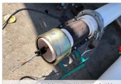
HDPE套管曳引鋼索安裝
