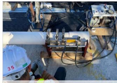
HDPE套管熱熔對接
