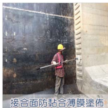
節塊拆模後接合面完整
