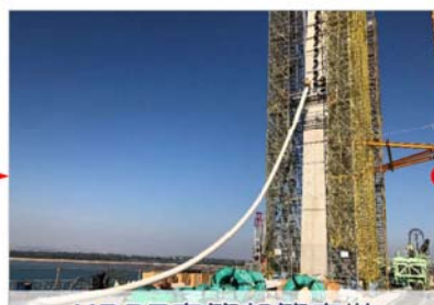
HDPE套管起管安裝
