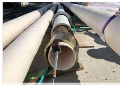
伸縮管組安裝於HDPE套管
