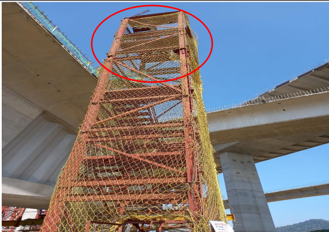
109.11.27 第 C714 標 PE3 潭聯(第一停留點)防護網有破洞
