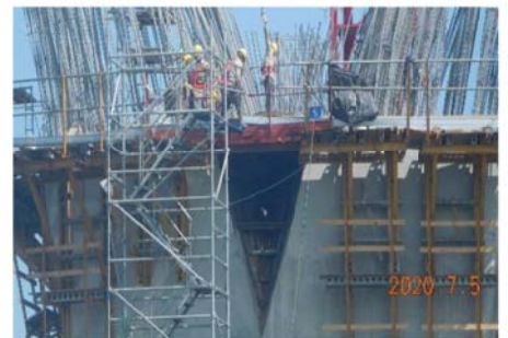
造型變化採鋼模組立
