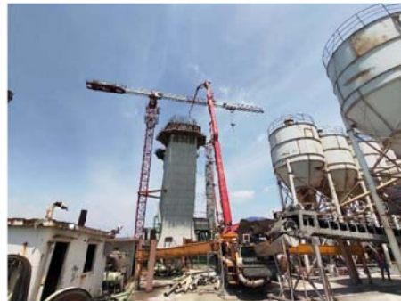
拌和船澆置現況
