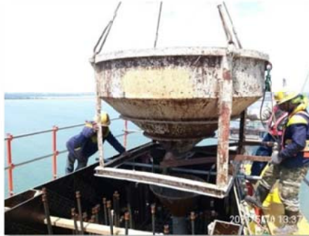
吊桶+卸料管澆置(橋塔)
