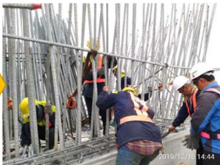
鋼筋保護層調整
