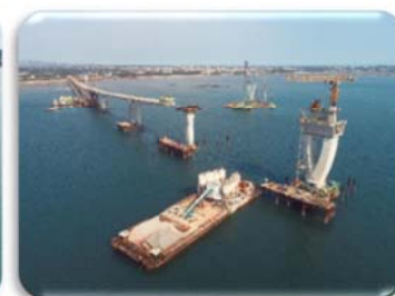
拌和船協助澆置作業
