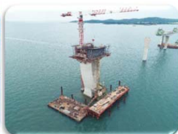
各墩配置施工構台或平台船
