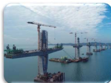
主橋配置塔式吊車
