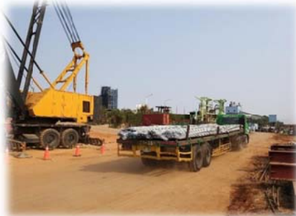
鋼筋載運進場
