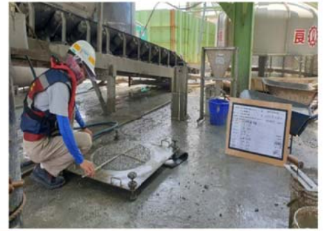
混凝土坍流度試驗
