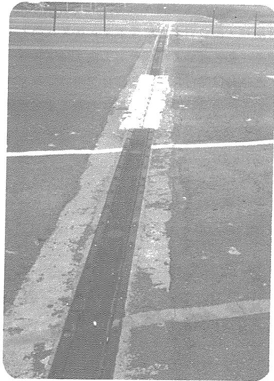
混凝土與路面縫隙填補情形
