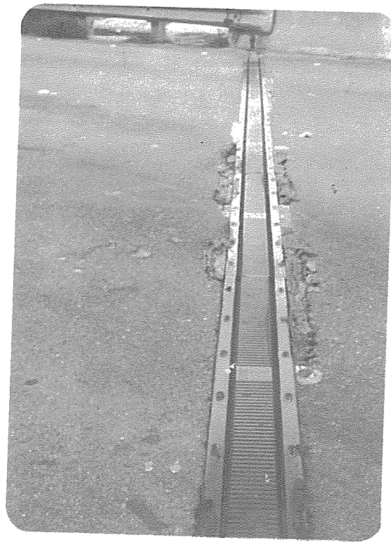
新型填縫劑施工快速，但材質不良通車後易於脫落情形
