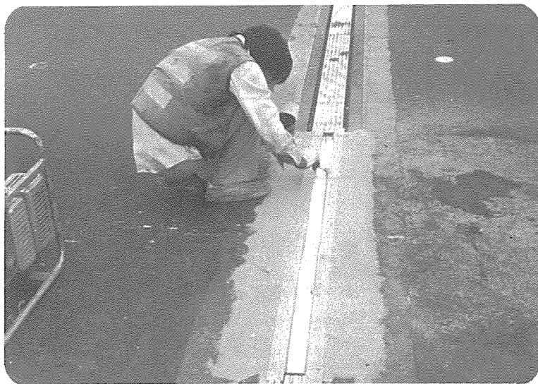
合成橡膠伸縮縫損壞改以環氧樹脂砂漿填補情形。
