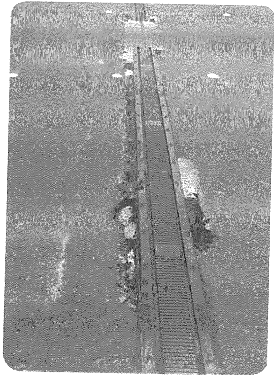
填充料材質不良，粘着不良情形
