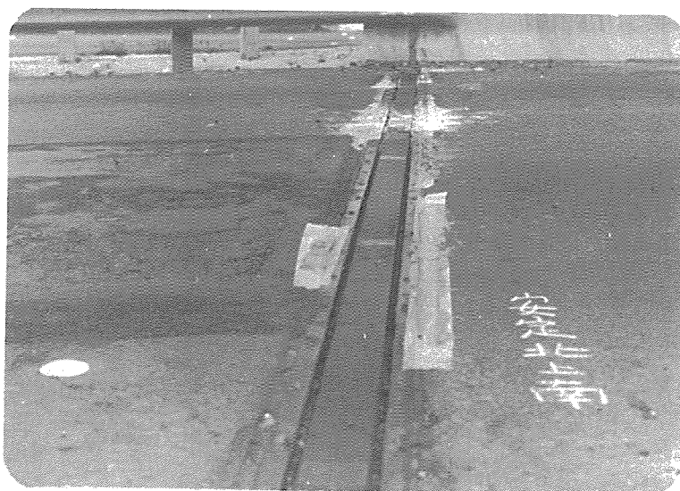
橋樑引道路面沉陷引起填縫料破碎情形
