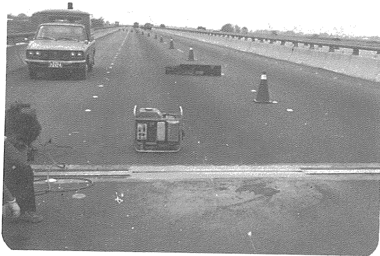
交通管制路幅半數施工維持通車情形
