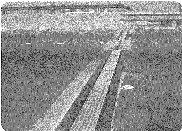
原有伸縮縫伸縮量不足擠壓破損整修
