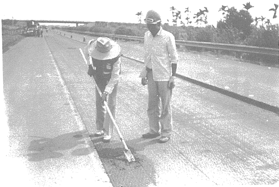
圖 7 施工層次結合不良需以人工鏟除
