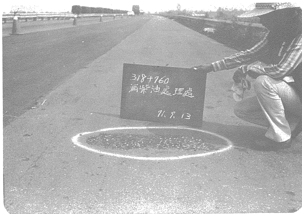
圖 11 施工中鋪路機具故障漏柴油處應鏟除修補
