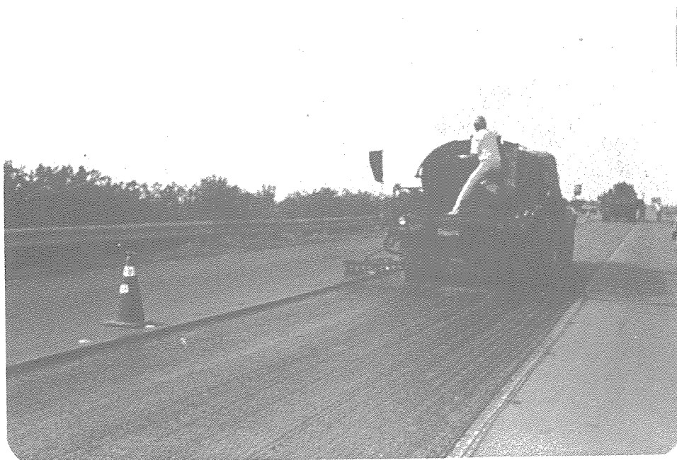
圖 8 噴灑粘層並作用油量試驗
