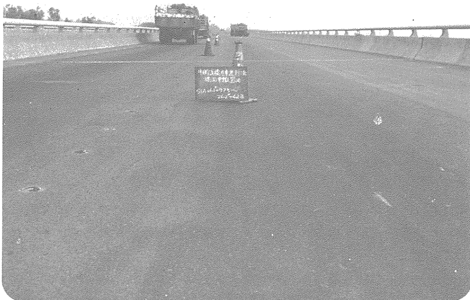
圖4 含油較多 流度較大
