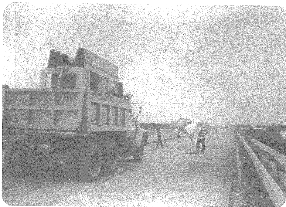
圖6 清除AC 路面刨除後以大型空壓機
