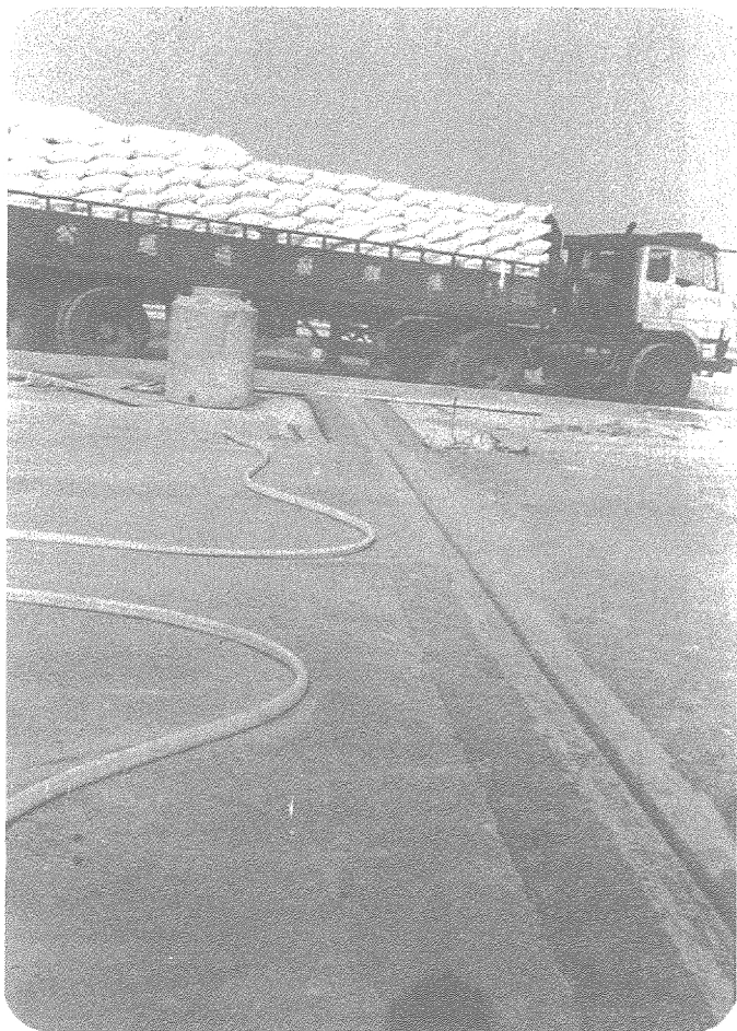
照片十四 螺帽孔及伸縮縫與混凝土 相接縫均注入填縫膠
