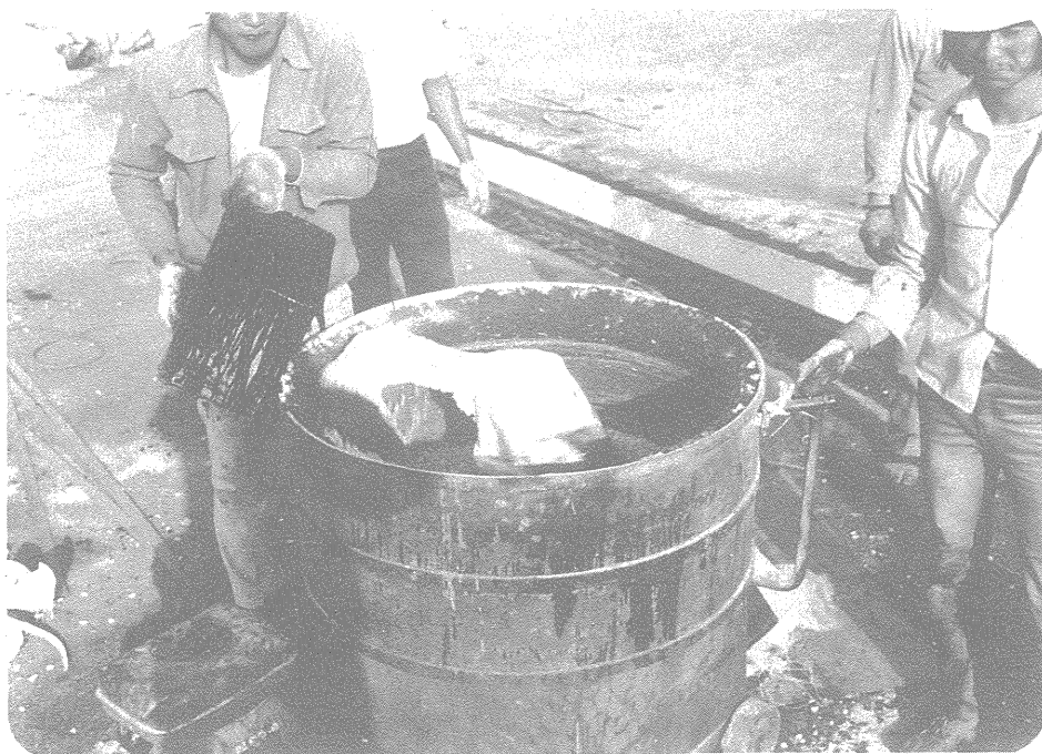
照片十一 用特製之拌合機攪拌 S B 混凝土（小桶裝黑色為已拌好的 SHO-BOND）
