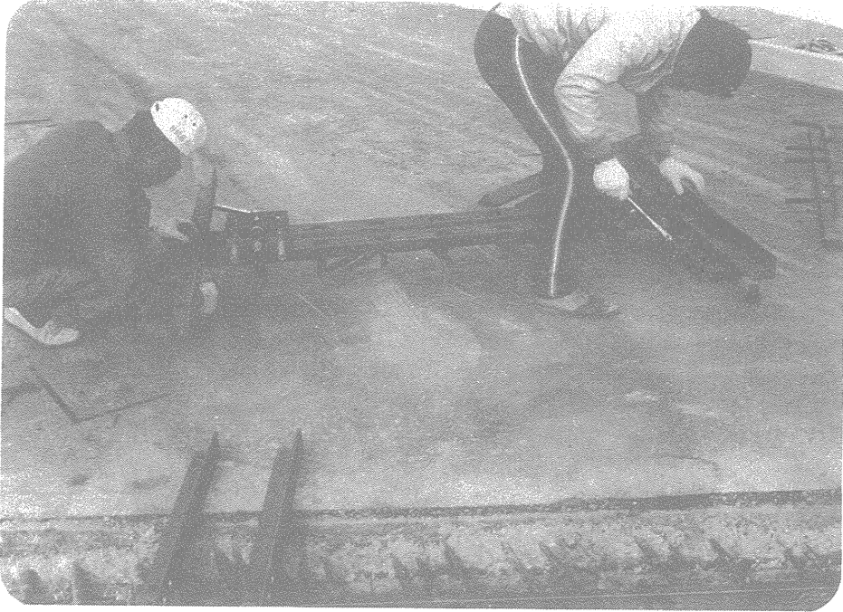
照片四 橡膠伸縮縫按圖示尺寸壓縮
