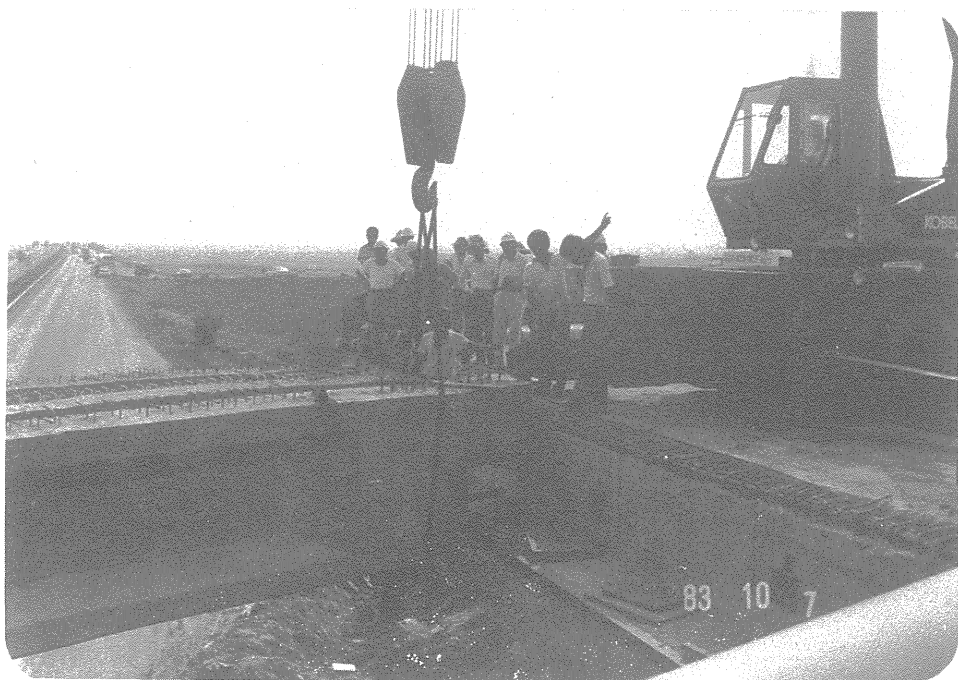
照片五 吊裝大樑情形
