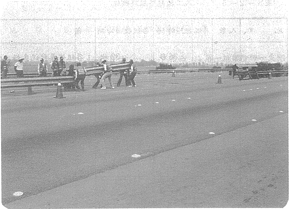
圖 8 - 2 - 15 人工抬起整組護欄組時一端已抬起另一端呈卡住情形
