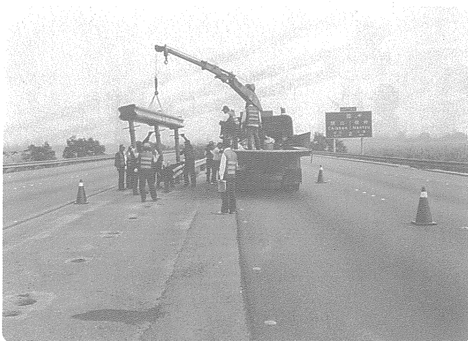
圖8-2-40 以工程救險車吊裝整組護欄組撤除後裝回作業之吊放情形
