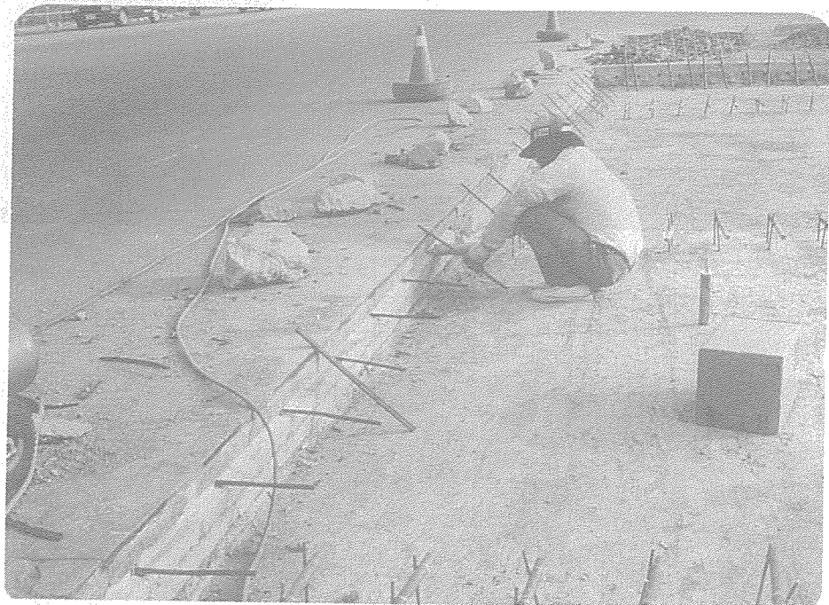
圖 8-3-17 接縫鋼筋設置
