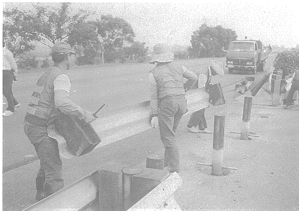
圖 8 - 2 - 32 人工拆解護欄組作業，鋼板及墊木螺桿一齊卸運情形
