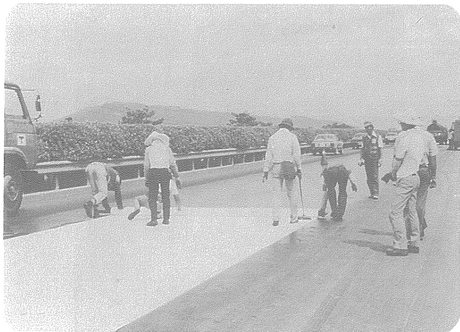
圖 8 - 5 - 14 人工鋪築工程織布
