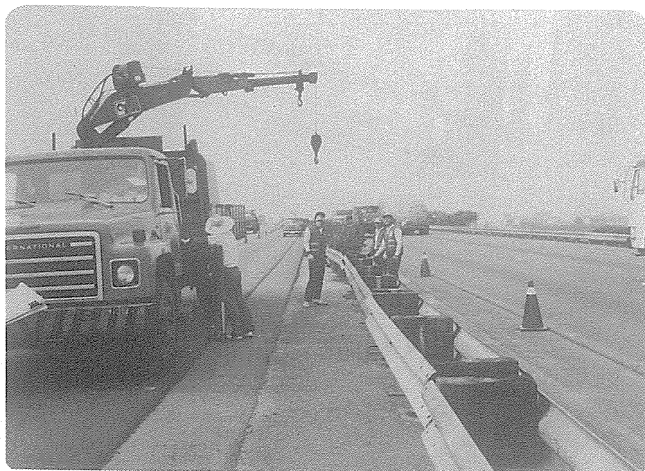
圖 8 - 2 - 35 工程救險車放置腳架及吊桿情形
