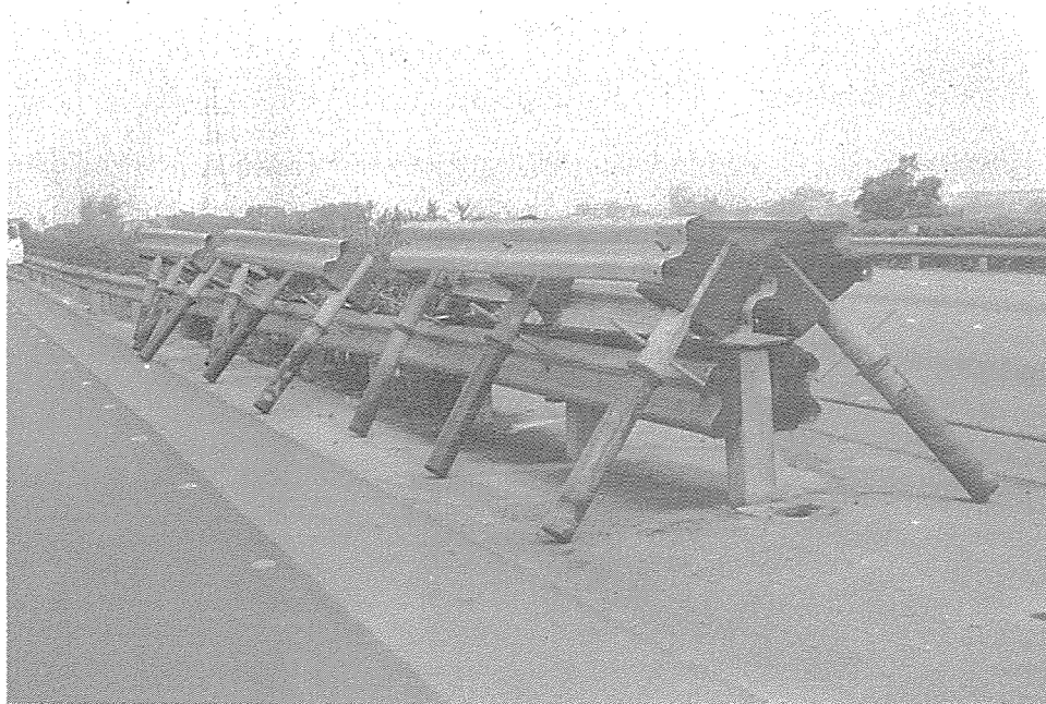
圖 8 - 2 - 17 人工抬起整組護欄組暫放兩端內側路肩情形
