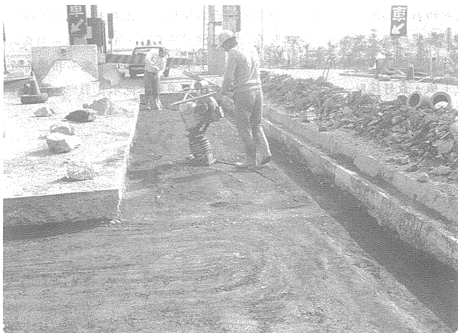
圖 8 - 3 - 15 敲除面整修及底層處理
