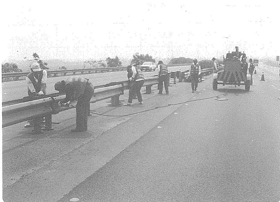
圖 8-2-25 人工配合機械拆解時使用空壓機及氣動扳手作業情形
