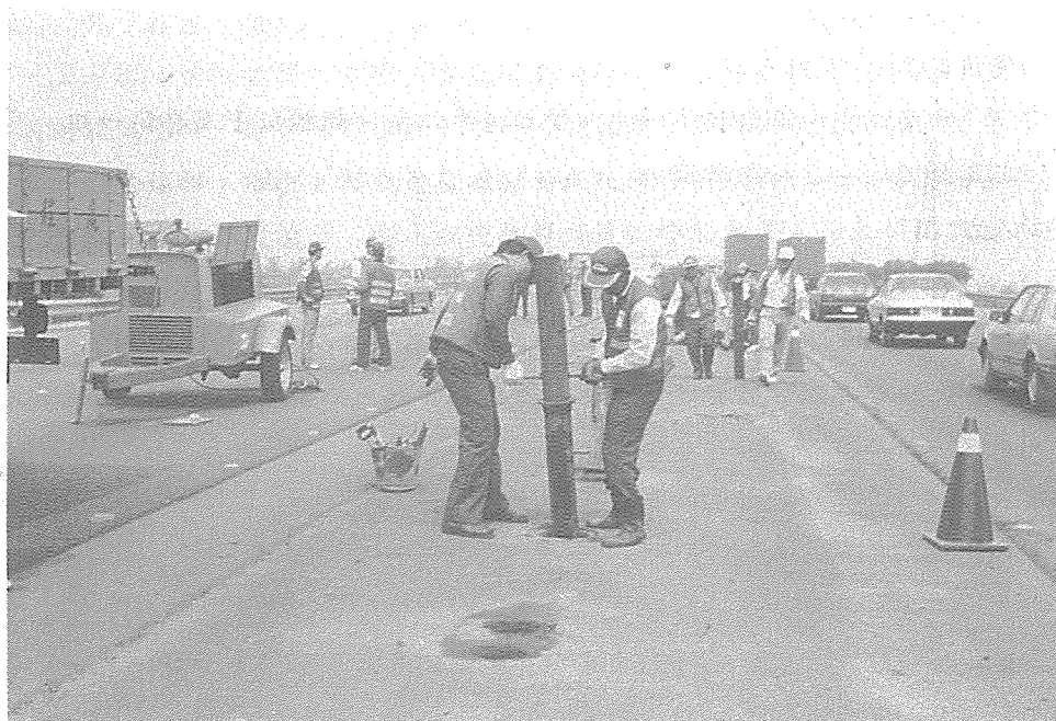
圖 8 - 2 - 27 人工配合機械撤除後鋼管柱運回放置孔洞情形
