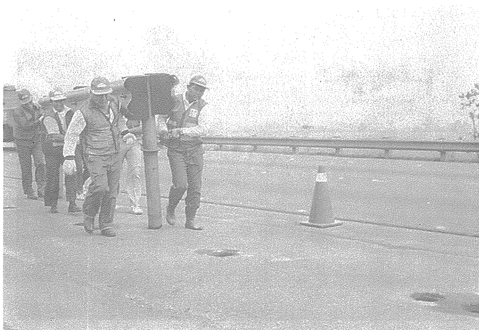
圖 8-2-20 人工抬起整組護欄組裝回情形（其中抬起時鋼管柱易碰觸路面）
