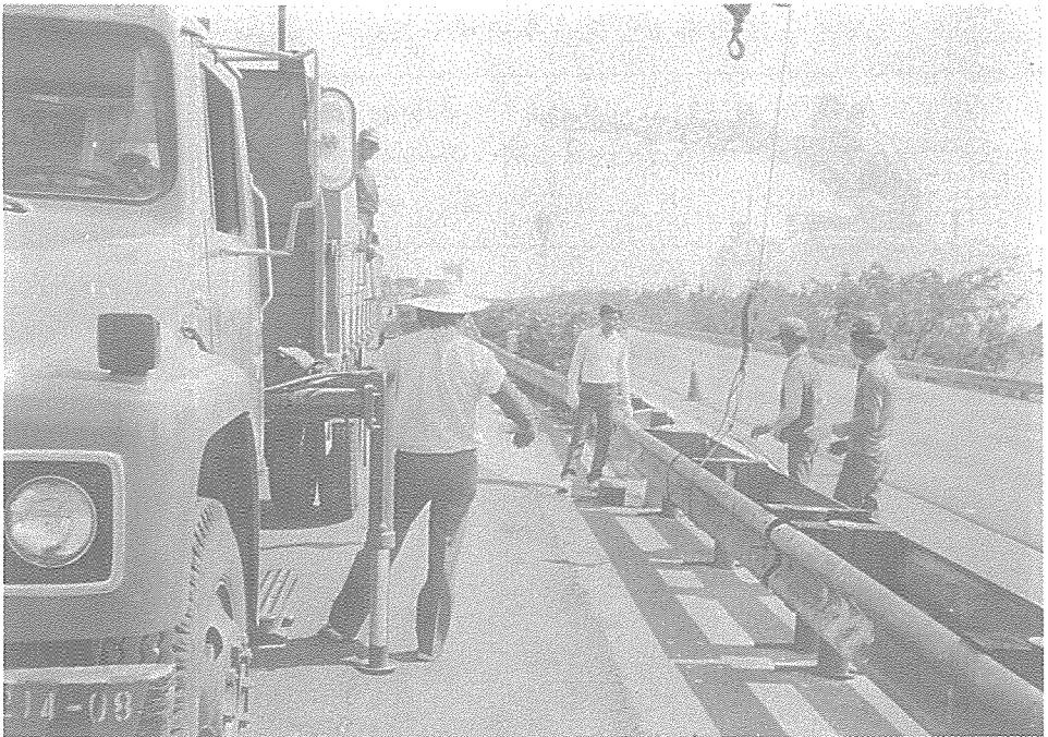
圖 8 - 2 - 37 以工程救險車吊裝整組護欄組拖吊情形
