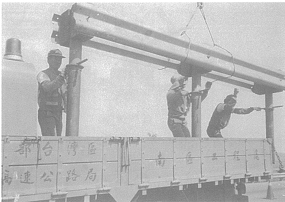
圖 8-2-38 吊放于工程救險車運離情形
