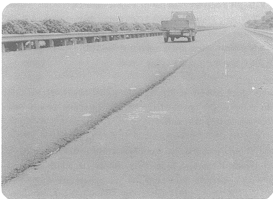
圖 8 - 5 - 16 路面側擠隆起情形
