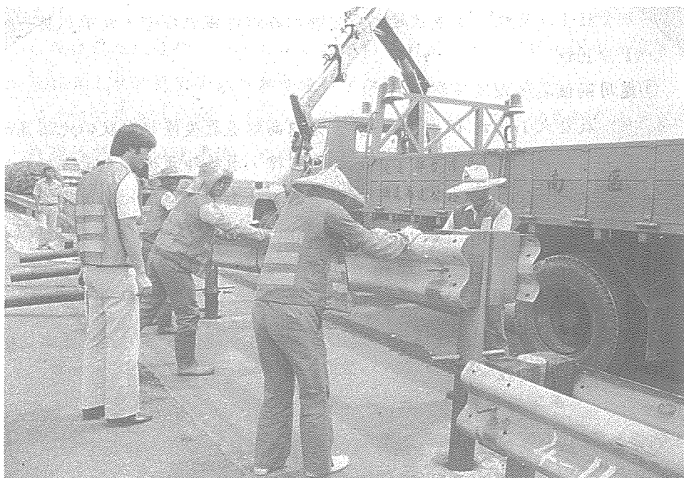
圖 8 - 2 - 42 以工程救險車吊裝整組護欄組作業時極易因施力不平衡而呈一端高一端低之現象
