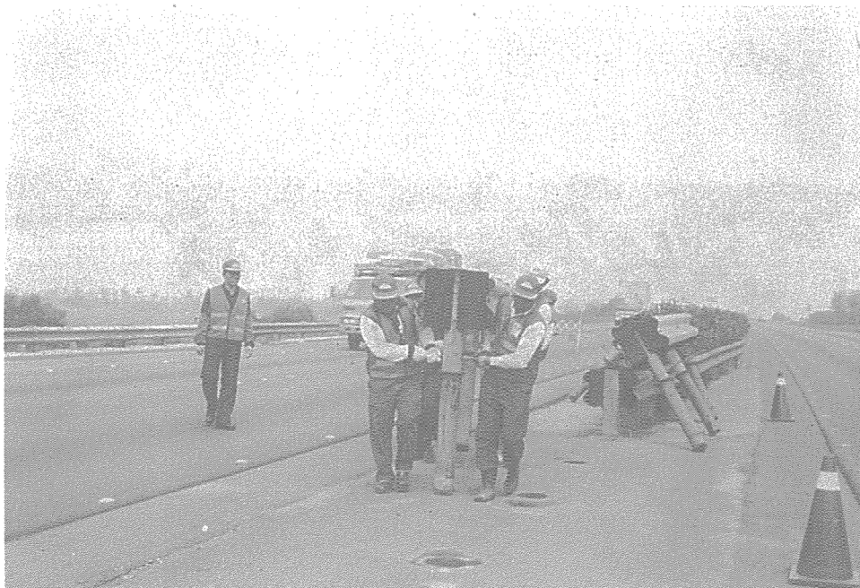
圖 8-2-19 人工抬起整組護欄組裝回情形
