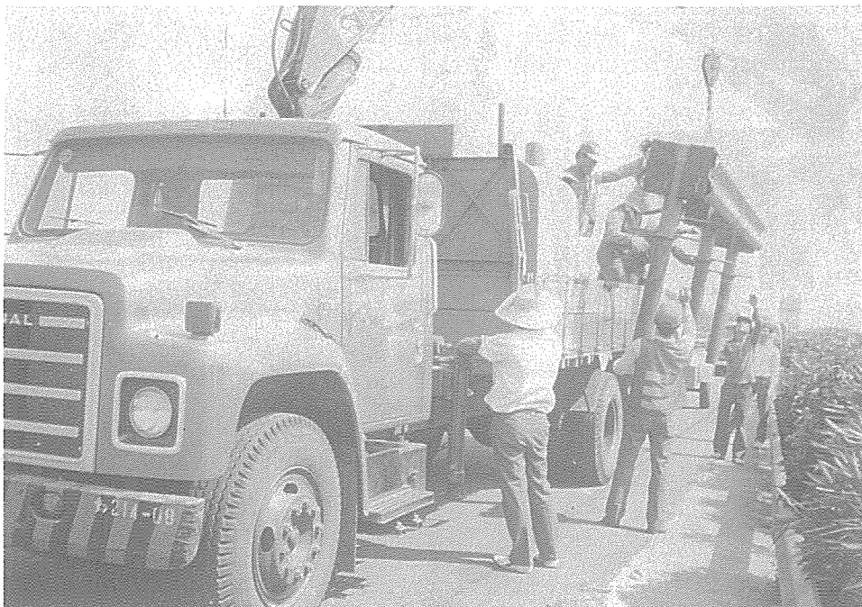
圖8-2-39 以工程救險車吊裝整組護欄組撤除後吊放于兩端內側路肩內之作業情形
