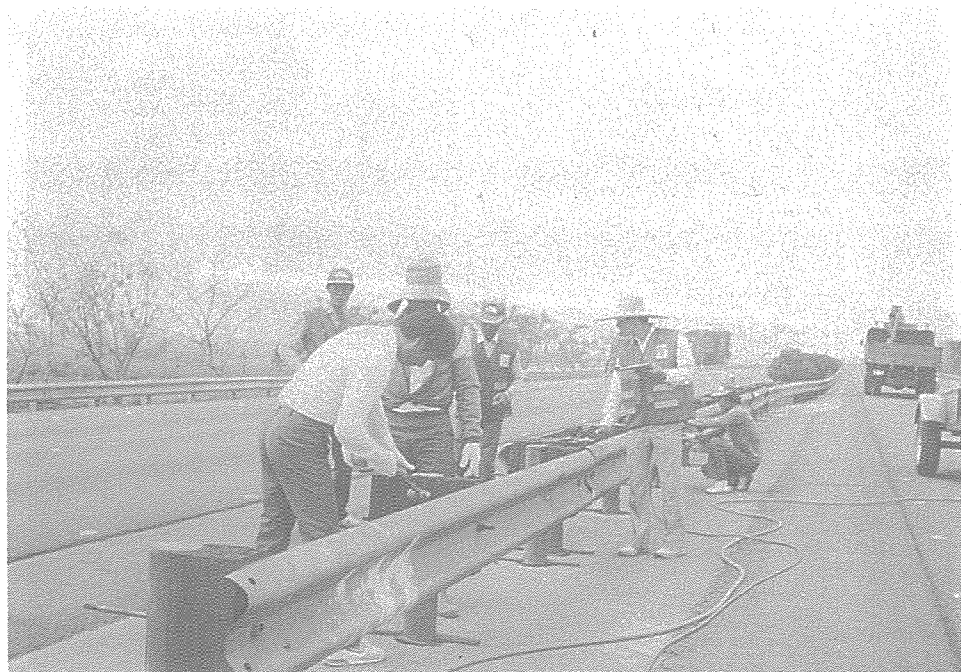
圖 8 - 2 - 31 人工拆解護欄組作業時墊木卡住以鉗頭敲除情形
