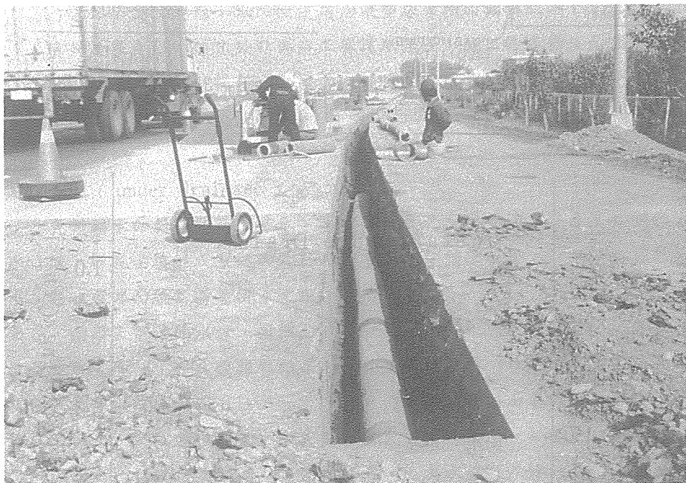
圖 8 - 3 - 25 底緣排水施工情形
