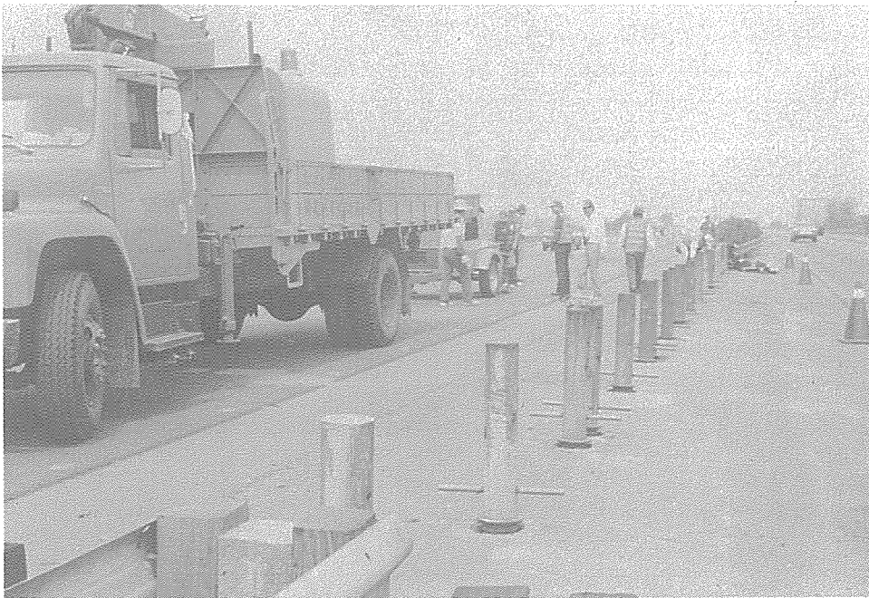
圖 8 - 2 - 24 人工配合機械拆解使用拖運之工程救險車
