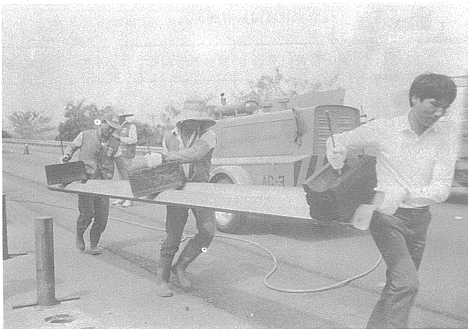
圖 8-2-26 人工配合機械拆解後鋼板及墊木螺桿一齊運離情形
