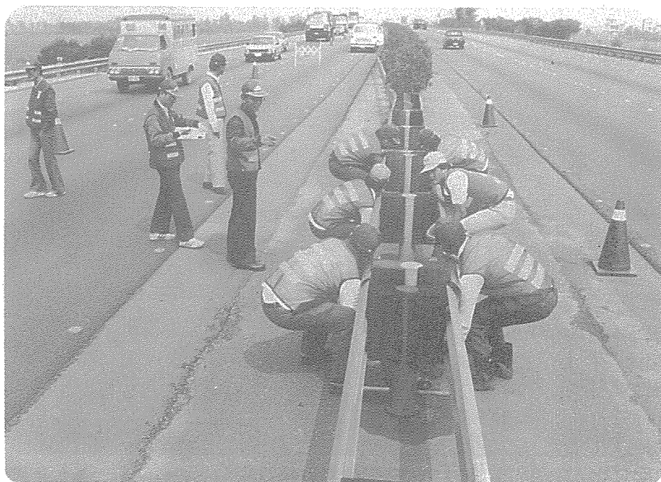
圖 8 - 2 - 14 人工抬起整組護欄組預備人員 蹲下情形
