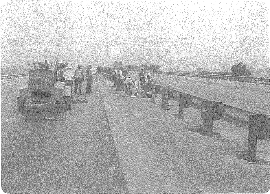
圖 8 - 2 - 23 人工配合機械拆解使用之空壓機
