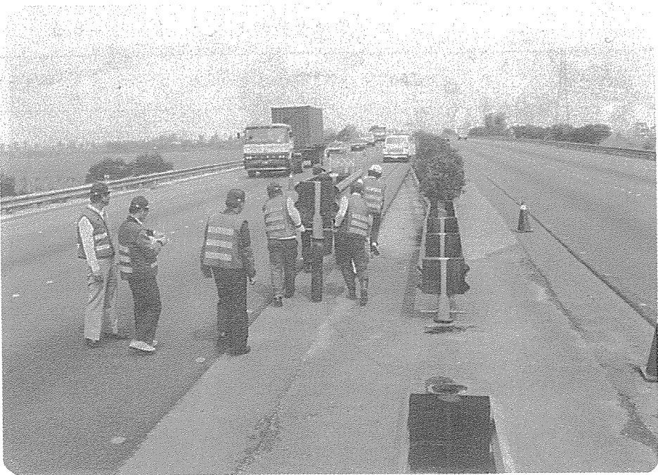
圖 8 - 2 - 16 人工抬起整組護欄組運離情形
