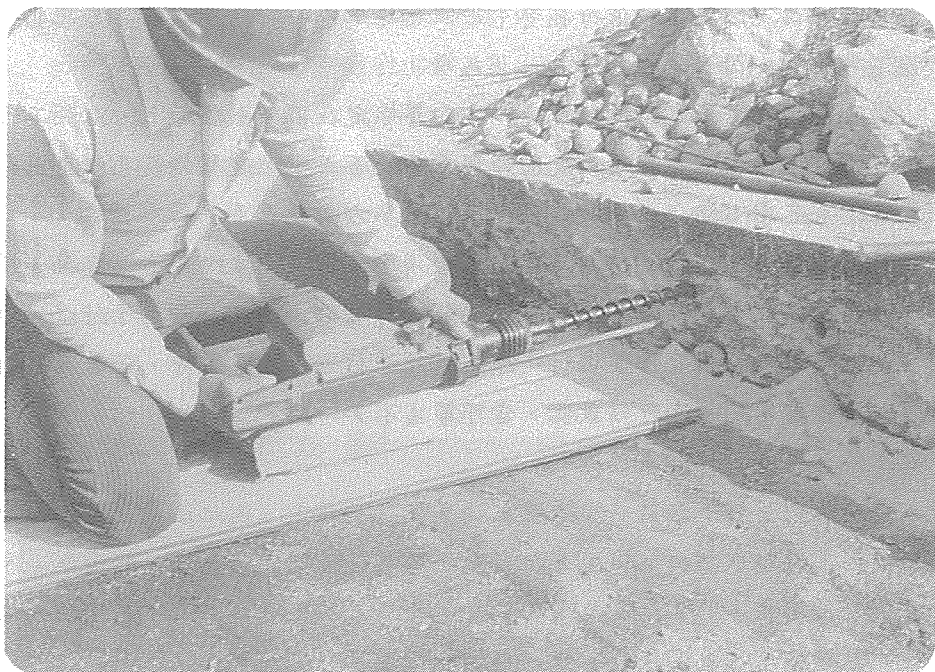
圖 8-3-16 鑽孔作業
