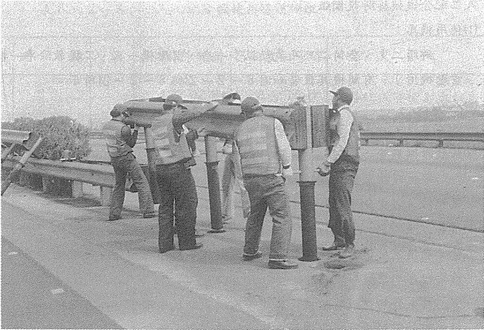
圖 8-2-21 人工抬起整組護欄組裝回時對準孔位放回情形
