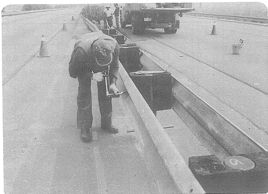
圖 8 - 2 - 30 人工拆解護欄組使用棘輪扳手作業情形
