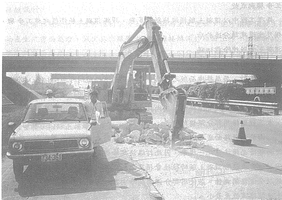
圖 8 - 3 - 14 混凝土版敲除及搬移
