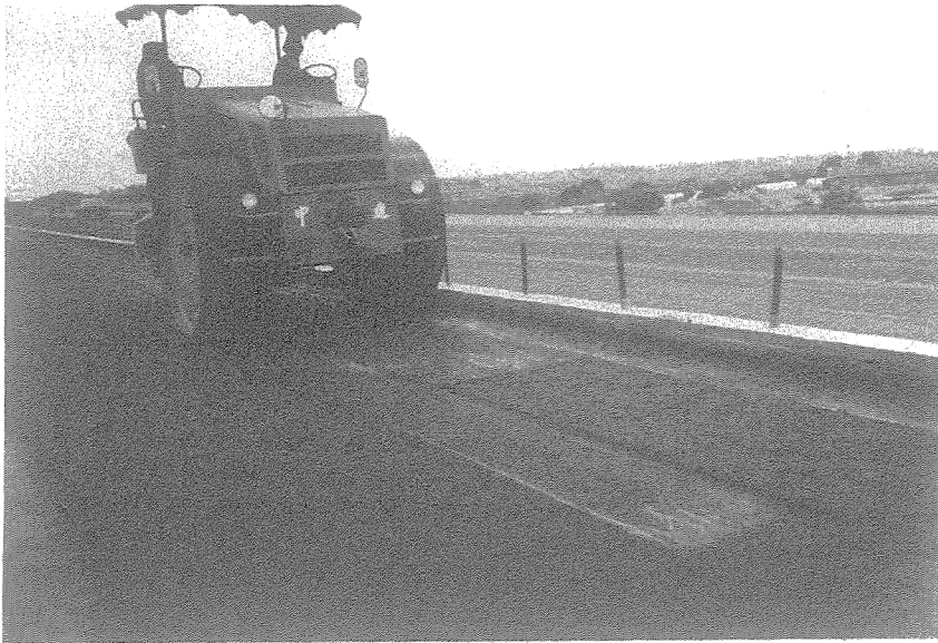
(圖三十六) 分層鋪築情形
