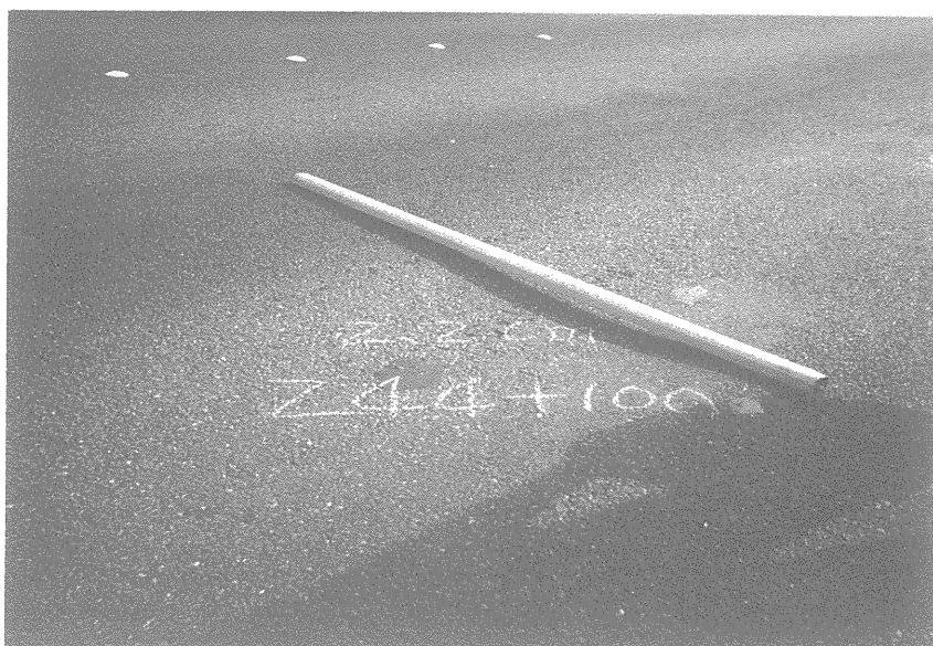
(圖四十二) 244k+100 南下外車道處路況 (車轍深度 2.2 cm、 輕微冒油)
