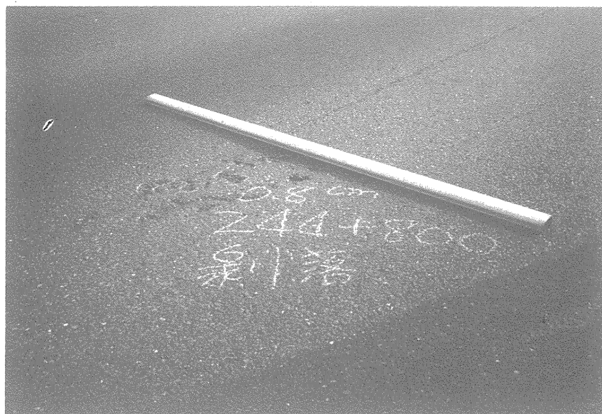
(圖四十三) 244k+800 南下外車道處路況 (車轍深度 0.8 cm、 粒料剝落)
