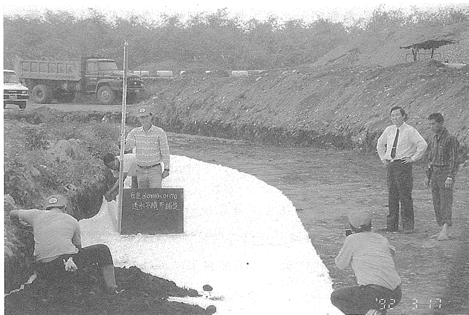
照片四 部份匝道軟弱路基換料並鋪設透水不織布
