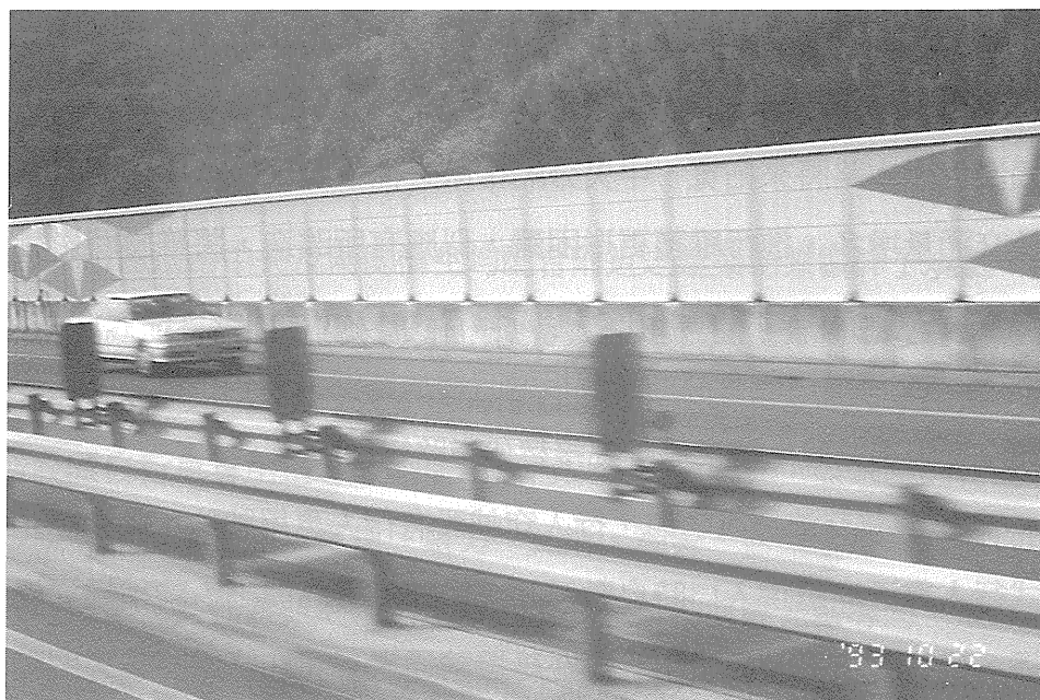
照片三 隔音牆上標繪簡單圖案防眩板4M裝置一片
