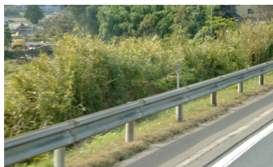
現況 3. 日本美作町沿線道路 郭瓊瑩 攝
