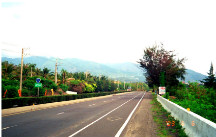
現況 11. 台 1 線屏東縣路段 李麗雯 攝
