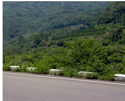
現況 17. 台 1 線屏東縣路段 李麗雯 攝
