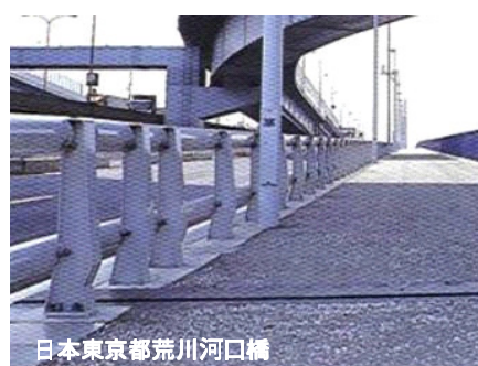
具視覺穿透效果之不鏽鋼護欄，材質與道路工程相關設施相同。
