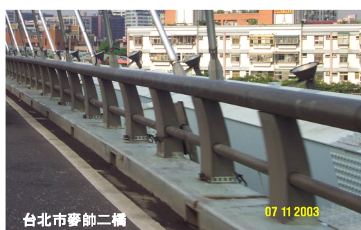
具視覺穿透效果之不鏽鋼護欄，材質與道路工程相關設施相同。
