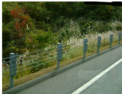
現況 8. 日本美作町沿線道路 郭瓊瑩 攝
