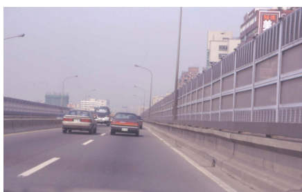
現況 1. 建國高架橋 郭瓊瑩 攝
