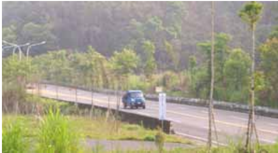
▲台 21 水社隧道前 路面與路側並無高差，護欄設施可去除(減法)，避免人為設施干擾路廊景觀風貌。
