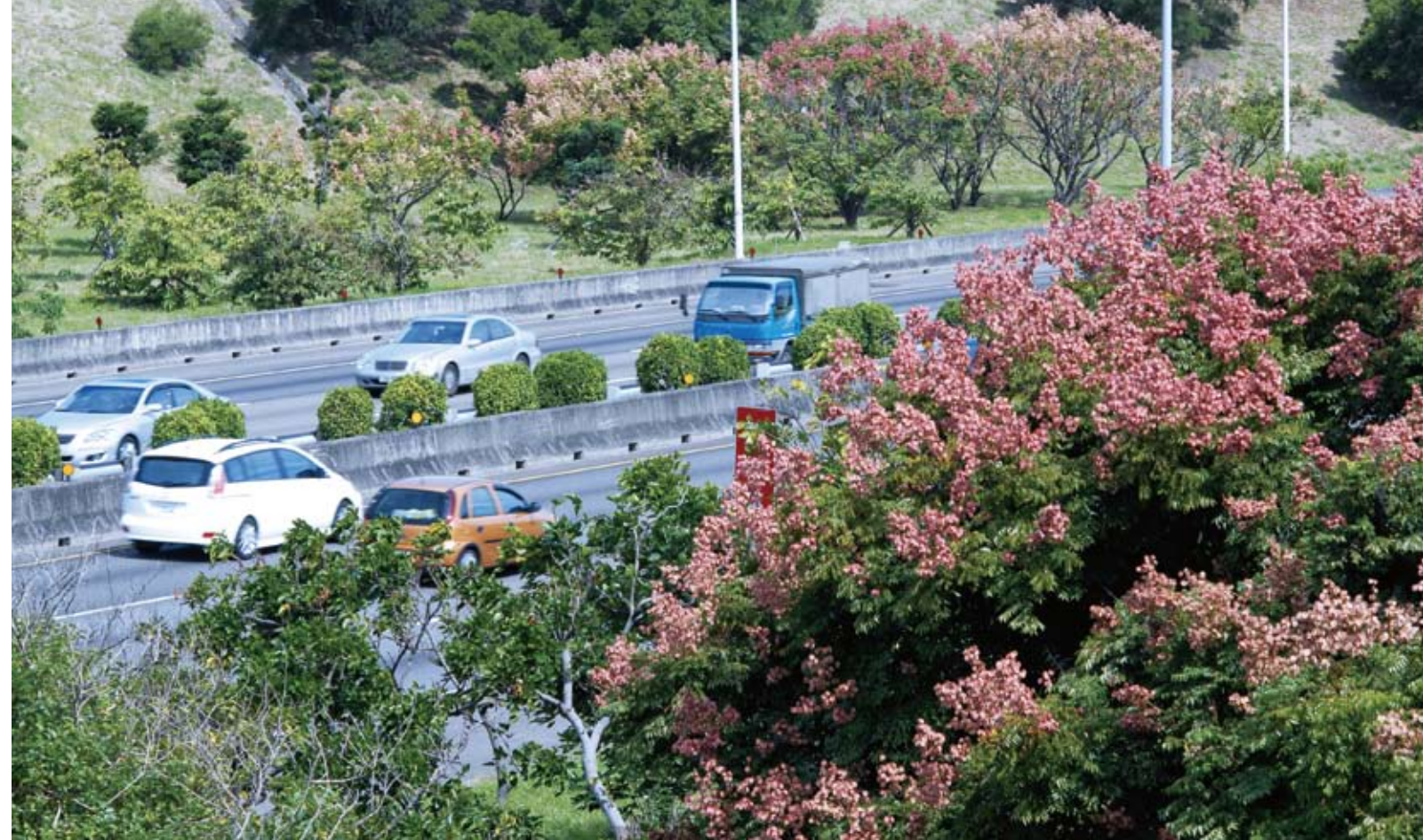
國道1號／中壢路段 Zhongli Section of National Freeway No. 1
