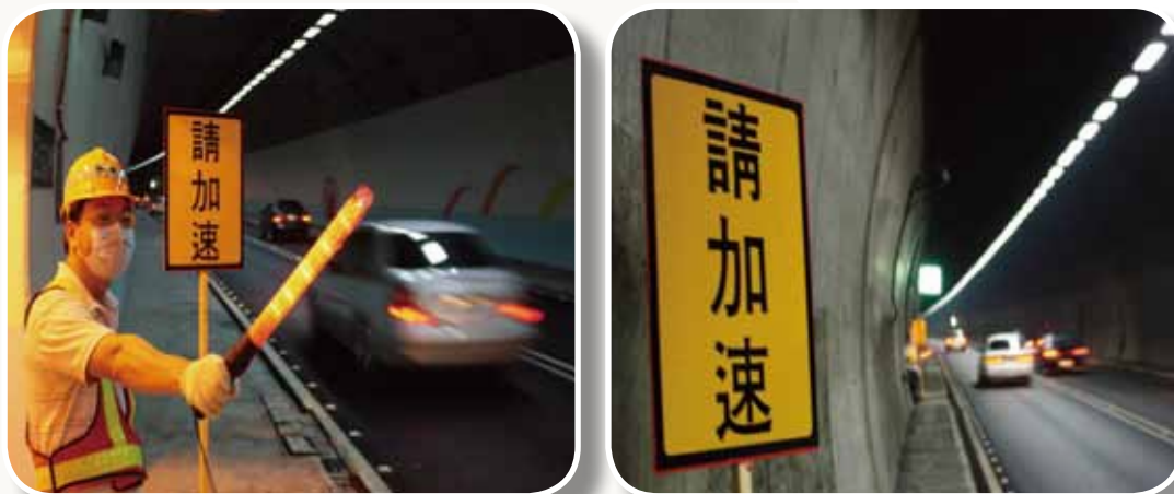
派遣人員於隧道洞口及中段指揮並設置相關告示牌
