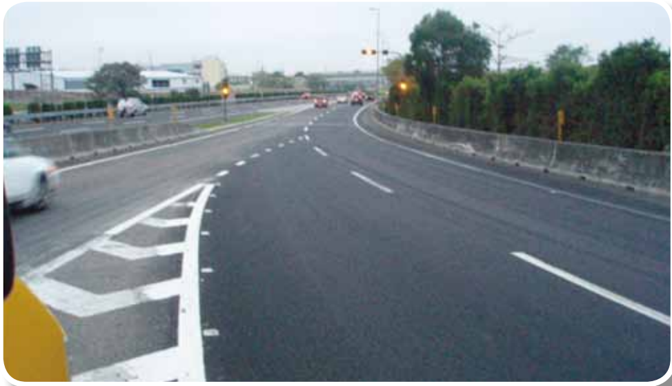
國道 4 號往國道 1 號南下匯流處改善前
