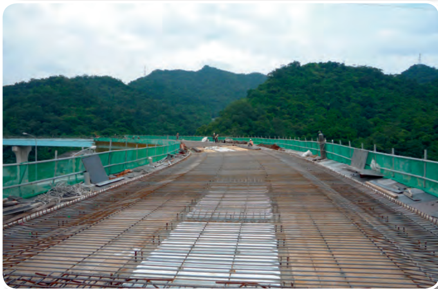
E匝道鋼橋面板鋼筋綁紮
