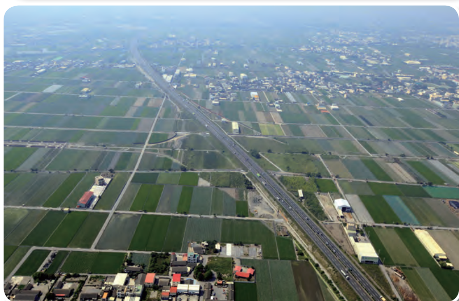
虎尾交流道工程施 工現場空照圖
