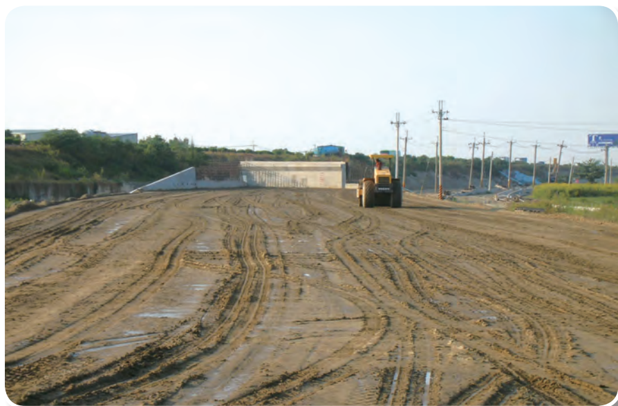
虎尾交流道工程路 堤填築作業
