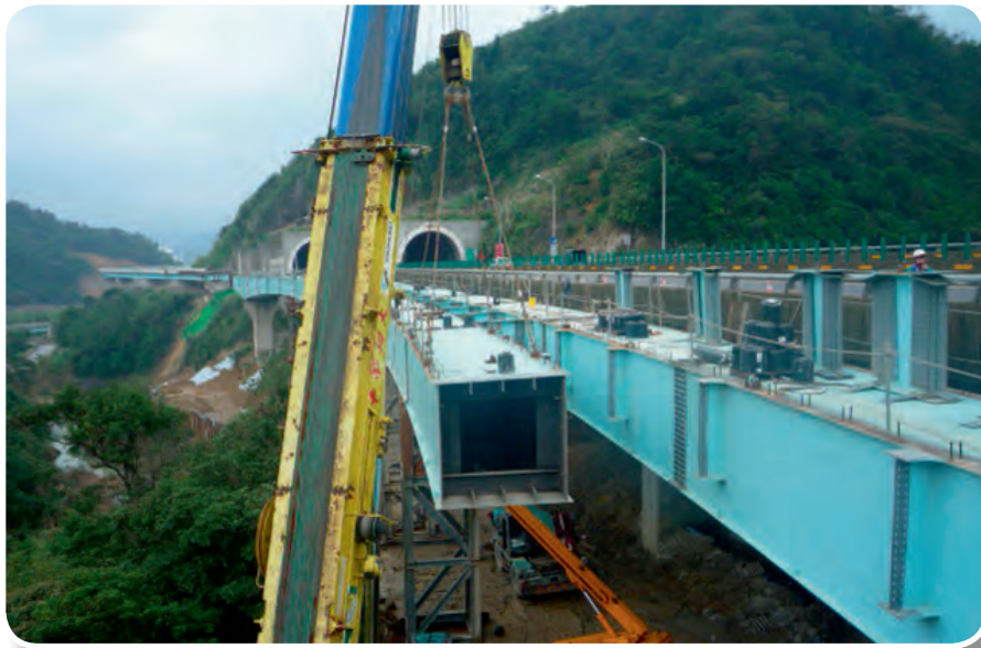
E匝道鋼梁吊裝
