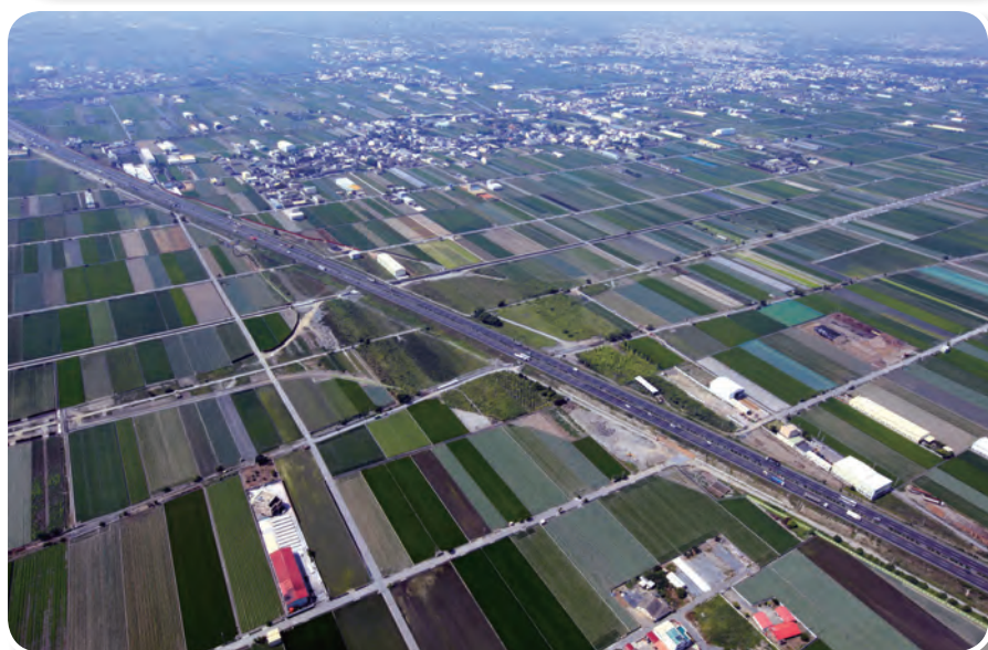
虎尾交流道工程施 工現況空拍圖
