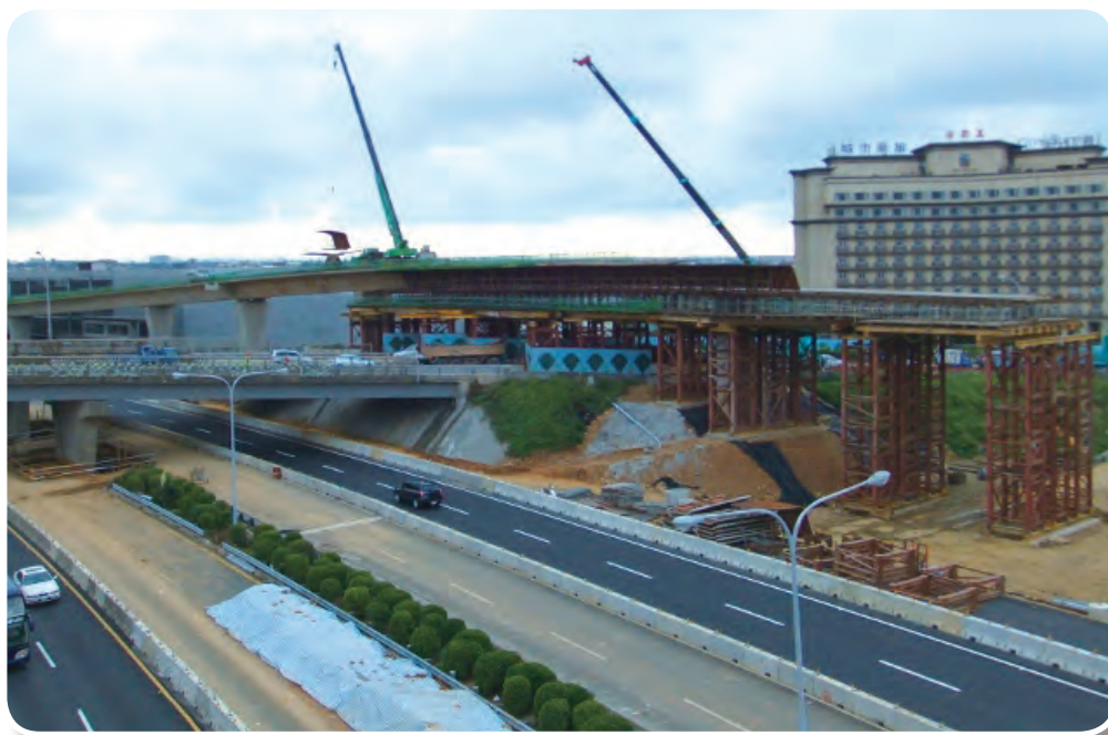
第H21A標東行線A3E-P42E場撐箱型梁施作
