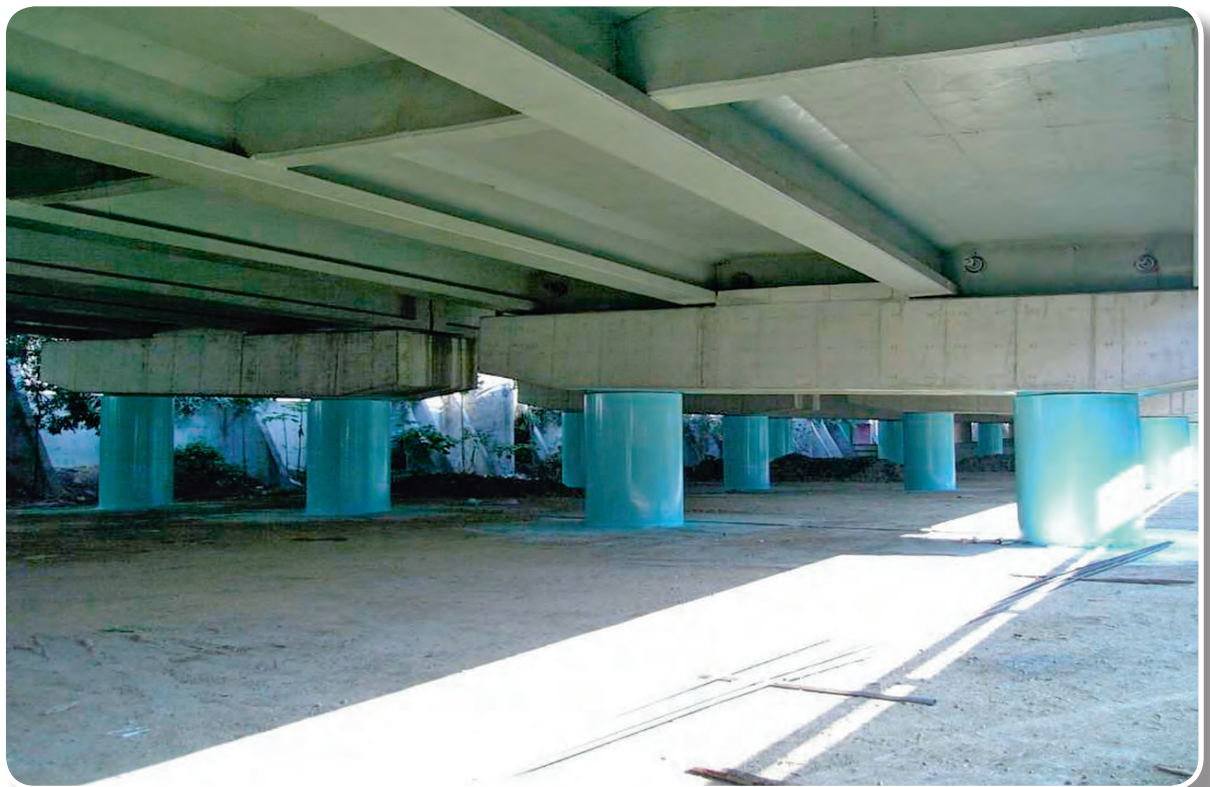
大直橋橋墩鋼板包覆補強
