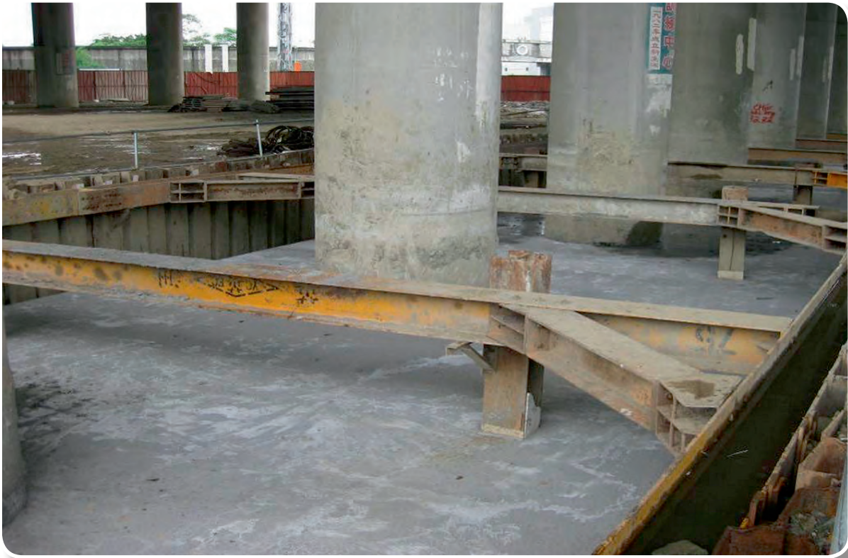
圓山北引橋橋墩基礎補強
