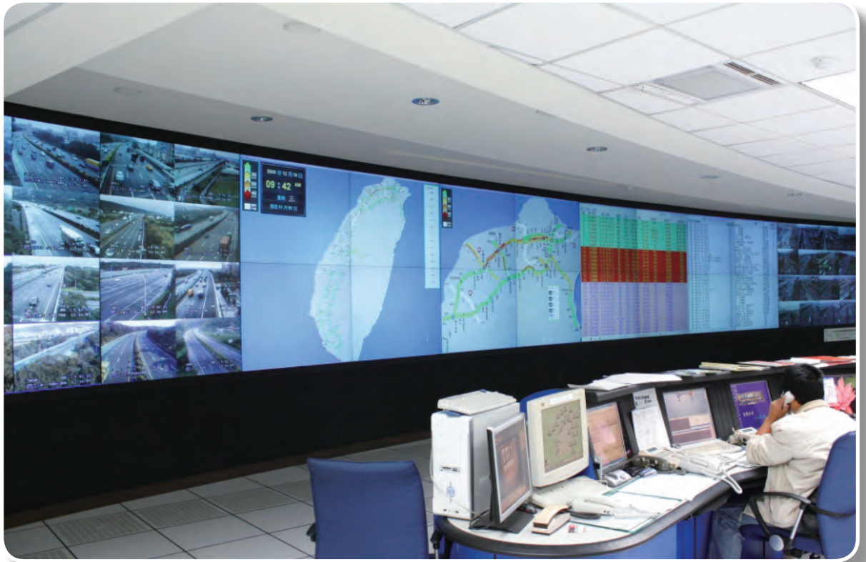
交控中心監視系統
