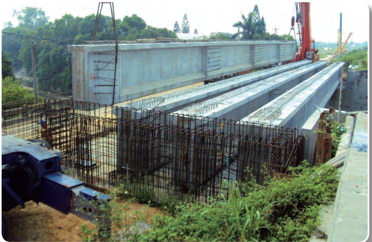
民雄交流道工程吊梁作業
