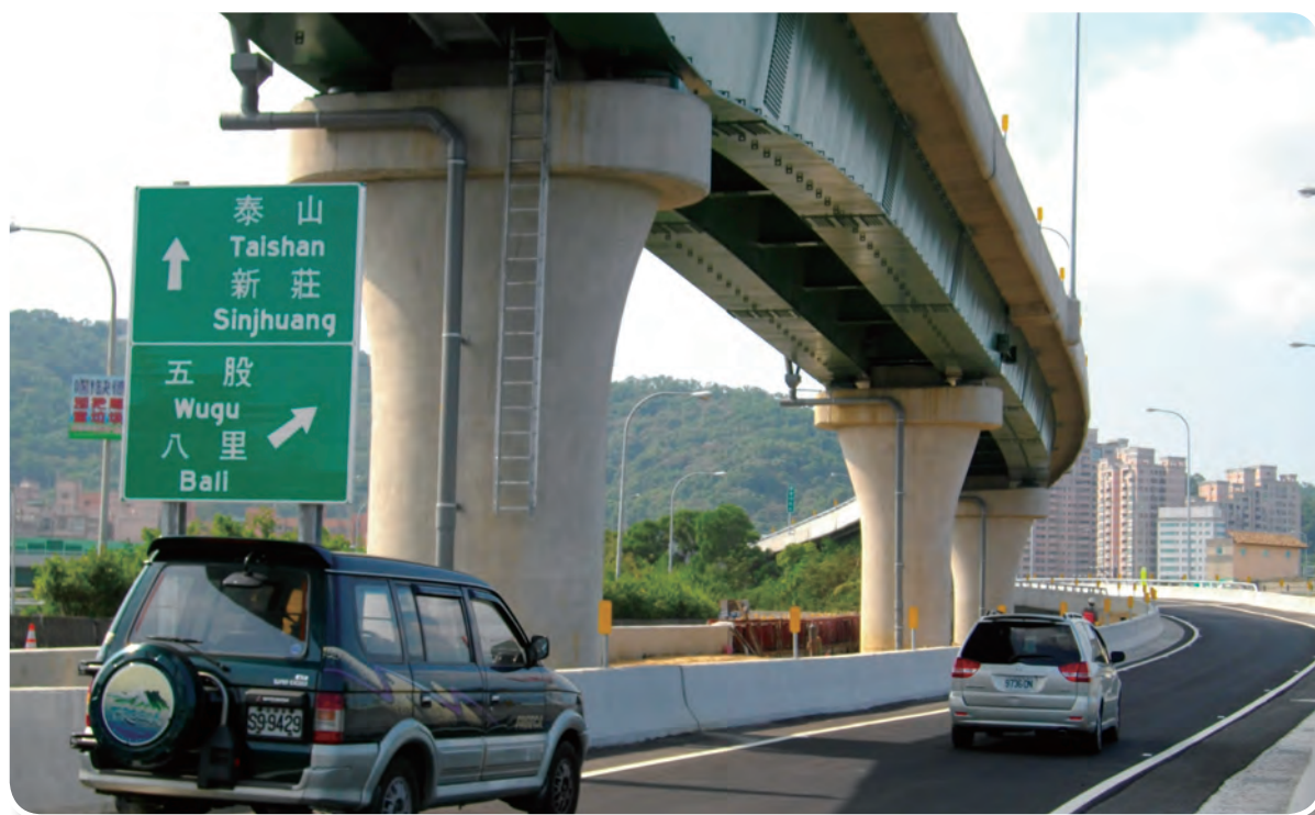
第204標－A匝道橋面版AC鋪設完成
