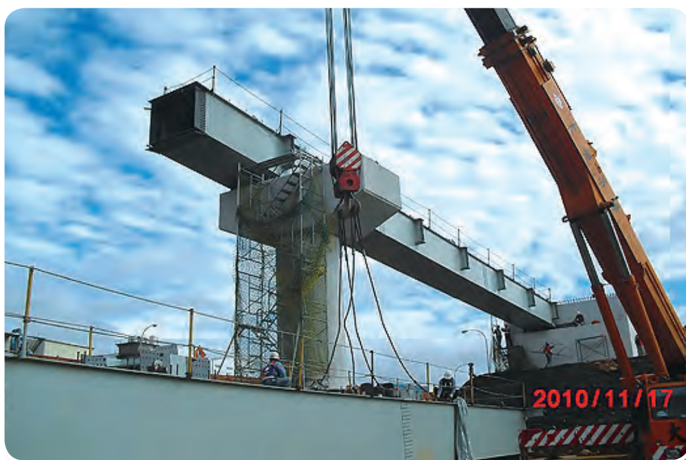
第H61標匝道4第5單元鋼箱梁吊裝
