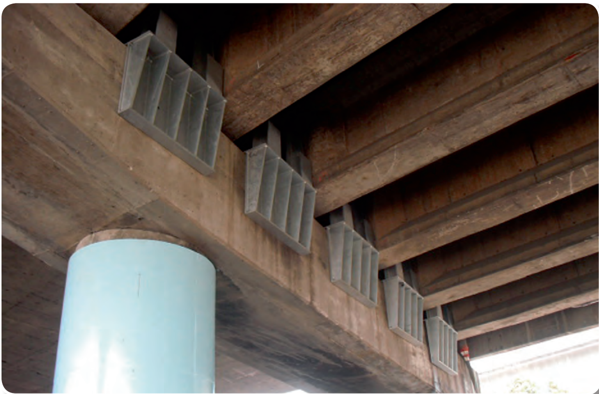
建國北路穿越橋鋼止震塊安裝
