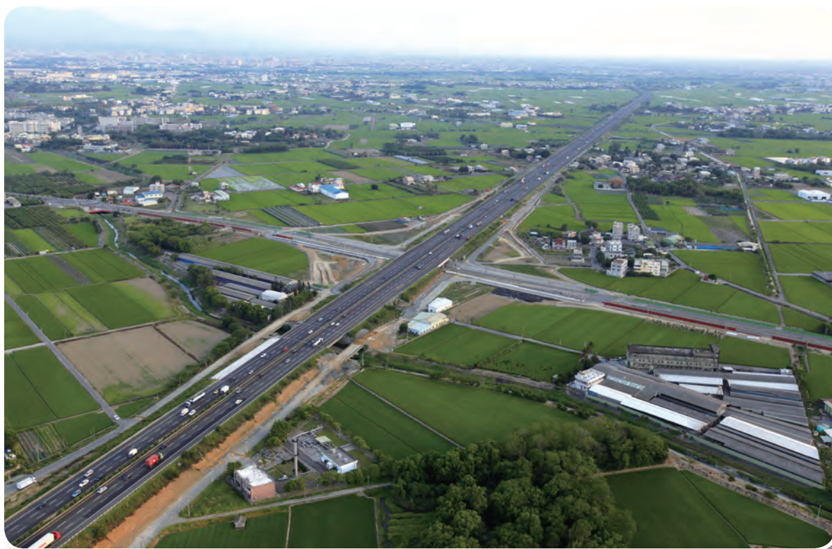
民雄交流道工程施工現場空照圖
