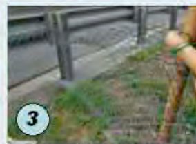
3 導引圍籬：防止動物進入高速公路車道
