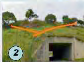
2 導引圍籬：引導動物使用廊道穿越國道
