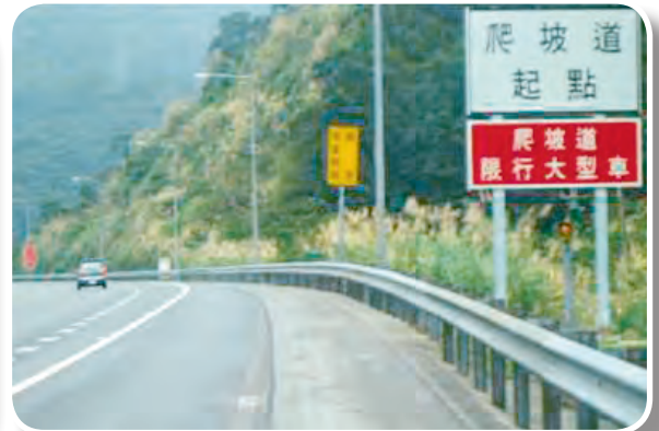
增設「大型車限行爬坡道」標誌
