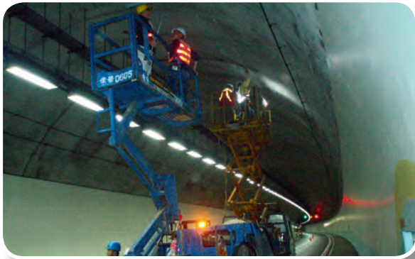
雪山隧道增設照明施工
