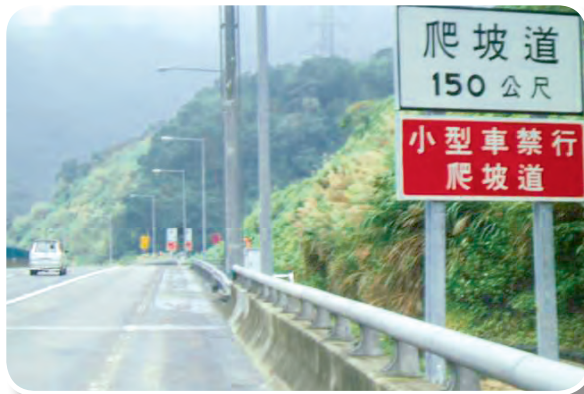
增設「小型車禁行爬坡道」標誌
