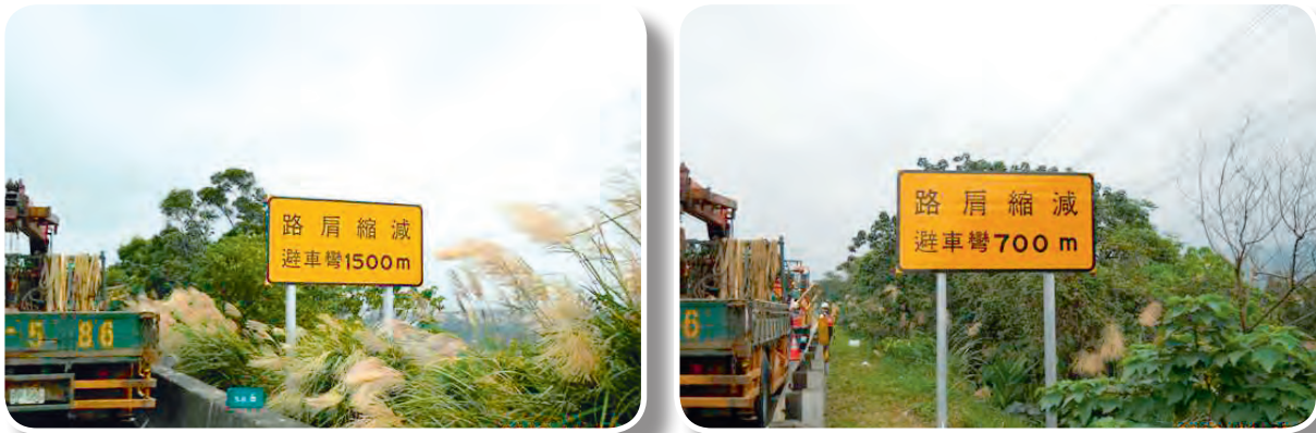
增設「路肩縮減」警告性質告示牌
