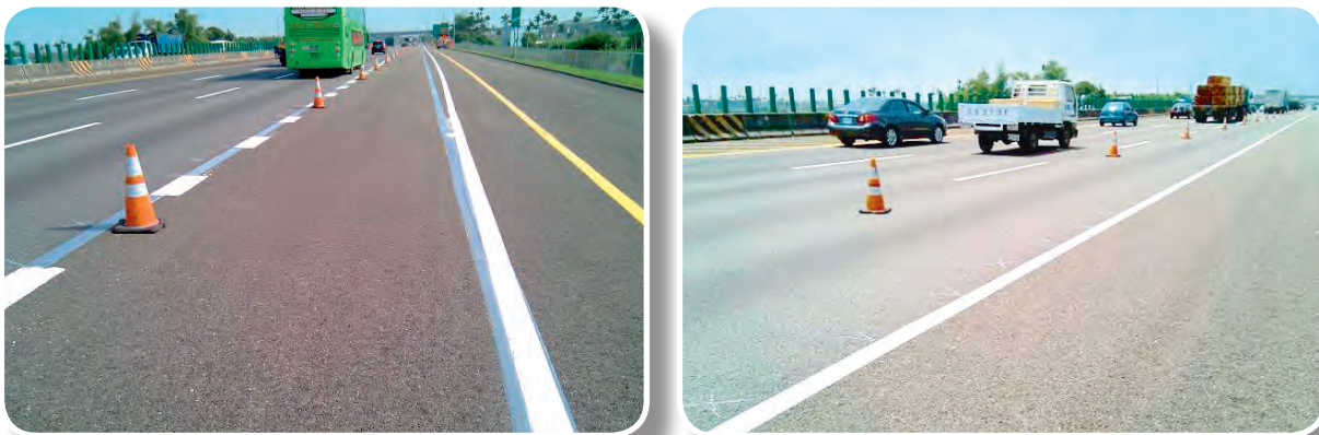
國道1號南下埔鹽系統交流道延長減速車道
