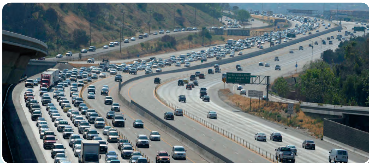
圖九：SR91為一東西向高速公路，其內側兩車道為電子收費車道。由照片中可明顯看出外側人工收費車道大排長龍，內側電子收費2車道則通行順暢。
