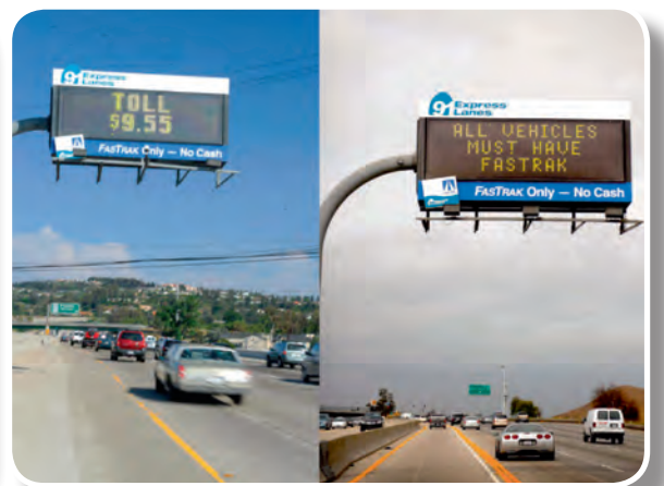
圖七：電子收費顯示螢幕，左側螢幕顯示費率，右側螢幕顯示電子收費專用車道。
