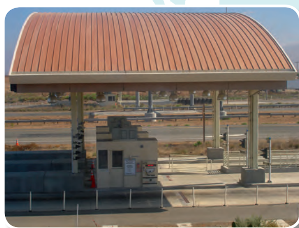
圖四：為實物照片，右側車道為電子收費專用道，左側為現金專用道。使用Tag之用路人不需停等繳費，可直接駛過收費區。
