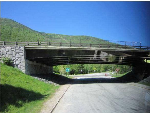
跨越橋橋台護坡多以大塊礫石鋪設
