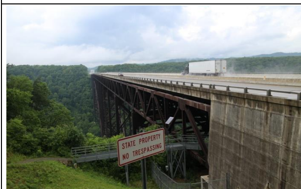
新河峽大橋全景
