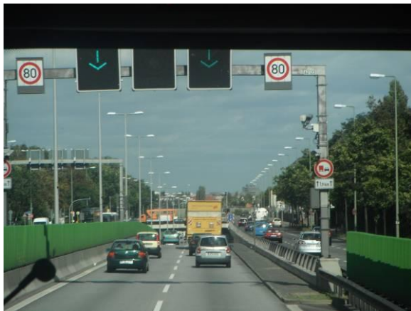
圖69 高速公路可變式車道管制號誌
