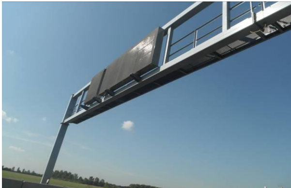
圖71 高速公路資訊可變標誌（門架輕巧）
